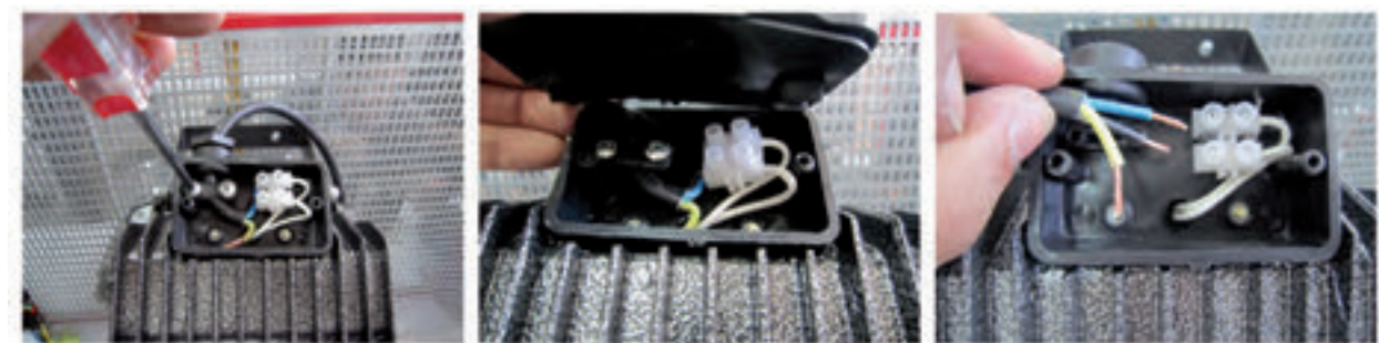
شکل ۲-۲۵ - سیم کشی در جعبه اتصالات
