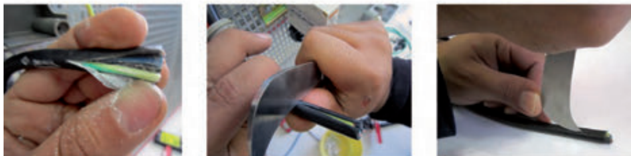
شکل ۲-۲۲ - بریدن و لخت کردن کابل
