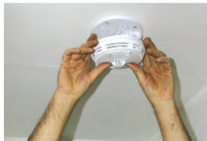
شکل ۱۵-۱ قرار دادن یک نوع آشکارساز روی پایه
