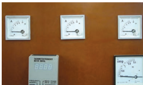
شکل ۶-۱۱- آمپرمترهای اندازه‌گیری جریان فازها
