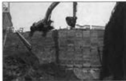
شکل ۱- ضرورت رعایت ایمنی در عملیات گودبرداری
