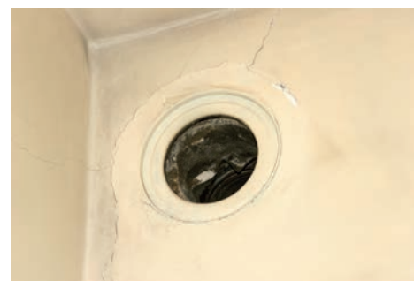
شکل ۱-۴ دودکش در محل نصب آب گرم کن.
