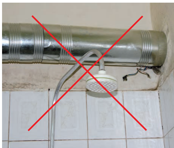
شکل ۳-۱۱ عبور غیر مجاز دودکش
