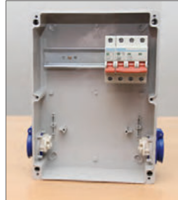
شکل ۲۲- نصب کلید جریان باقیمانده (نشستی)
