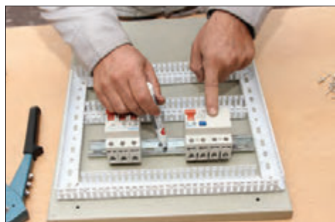
شکل ۴۲- محل نصب ریل فلزی
