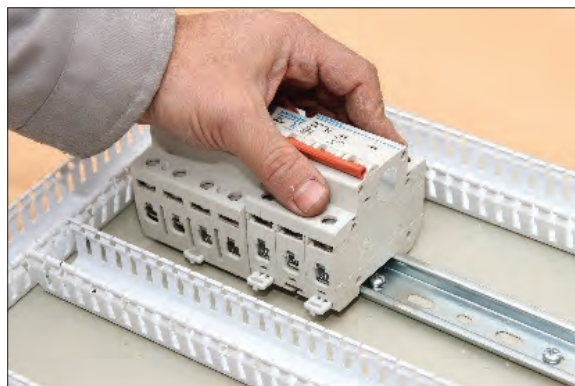
شکل ۴۶- نصب قطعات روی ریل
