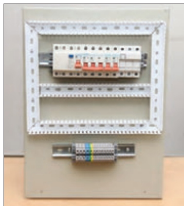
شکل ۴۷- نصب ترمینال‌های ریلی ورودی و خروجی و شینه‌های زمین
