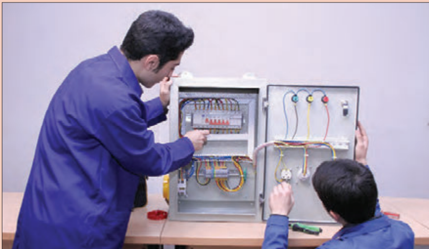
شکل ۳۰- قطعات الکتریکی و غیر الکتریکی تابلو برق
