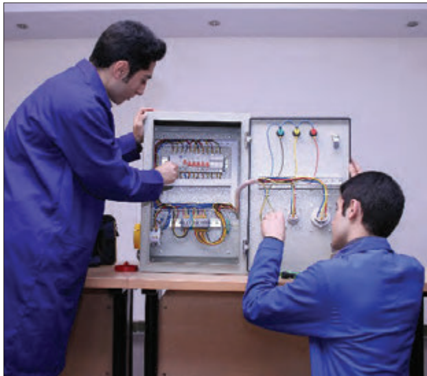
شکل ۲- تابلو برق فشار ضعیف
