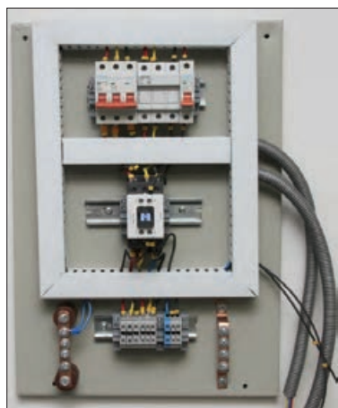
شکل ۹۱- تکمیل سیم‌کشی قطعات صفحه نصب
