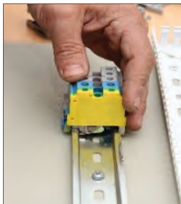
شکل ۴۷- نصب ترمینال‌های ریلی ورودی و خروجی و شینه‌های زمین
