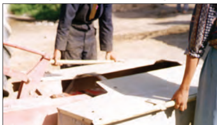
شکل ۶- پیاده کردن حفاظ
