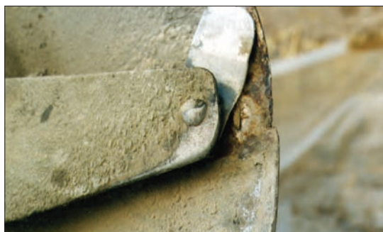
شکل ۴۲- خوردگی لبه استوانه
