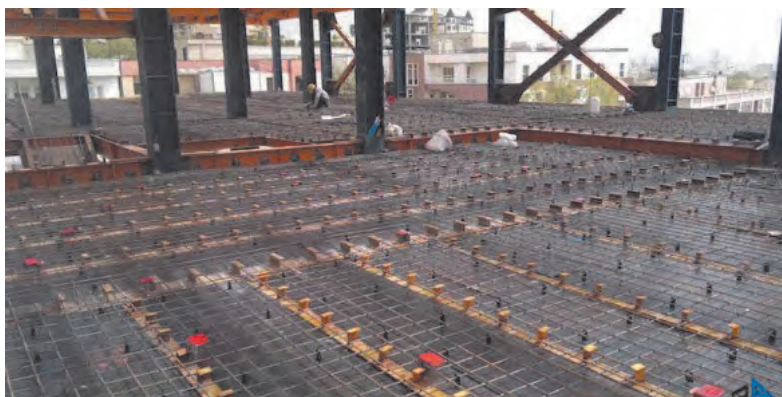
شکل ۳۲ ▲ سقف مرکب به همراه برشگیرها
