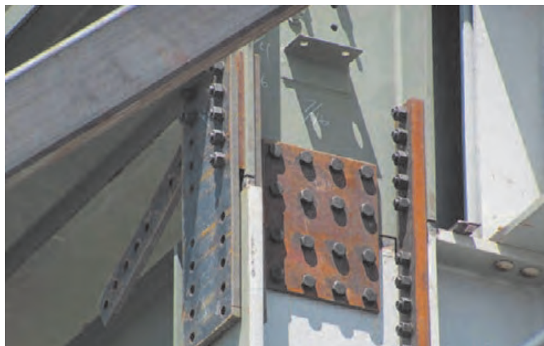
شکل ۵۷ وصله پیچی ستون
