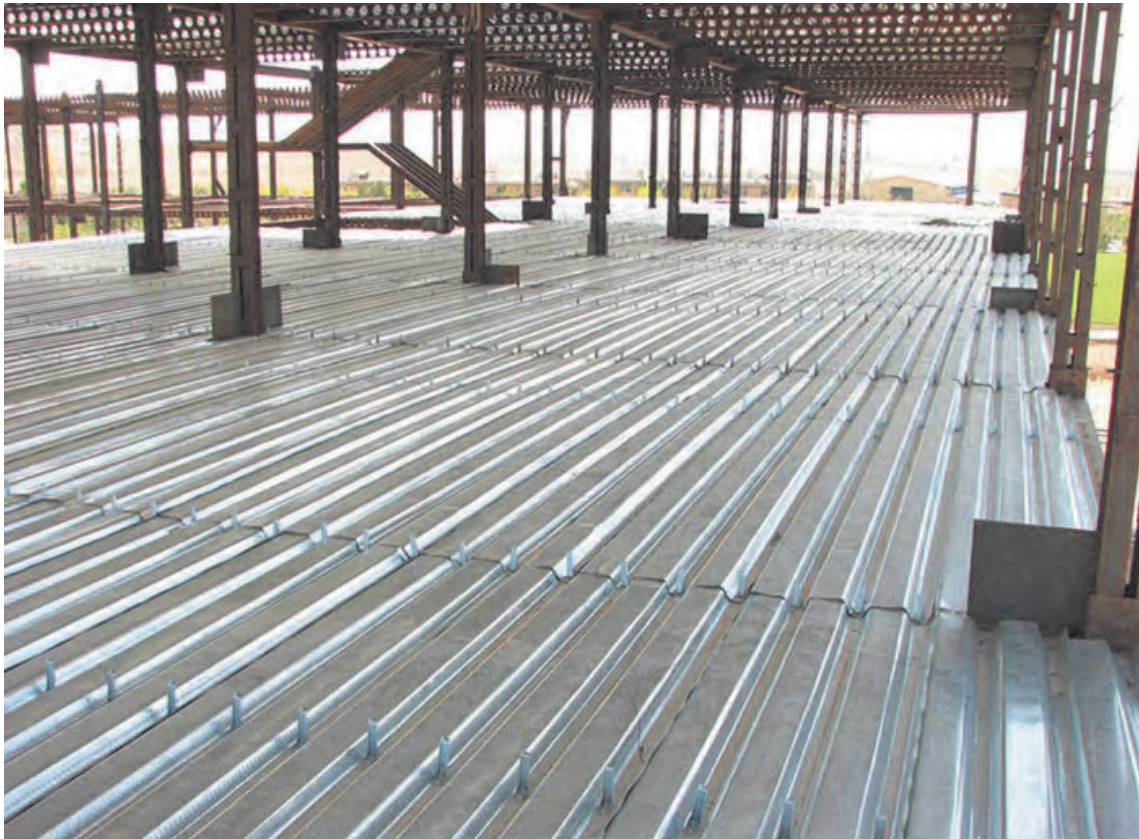
شکل ۳۳ ▲ سقف عرشه فولادی
