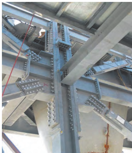
شکل ۵۱ ▲ اتصال مهاربندی
