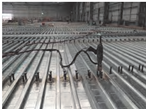
شکل ۳۴ ▲ روش نصب گل‌میخ روی سقف عرشه فولادی
