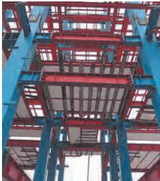
شکل ۶۰ ▲ قاب خمشی
