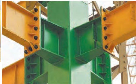
شکل ۵۰ ▲ انواع اتصال فلنجی
