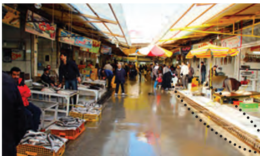
شکل ۲۵-۲- کف قابل شست‌وشو و مسیر جمع‌آوری آب با در پوش مشبک در وسط مسیر عبور در بازار ماهی فروش‌ها.
