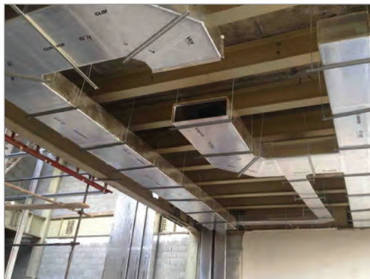
شکل ۱۹-۲- سقف با کانال تأسیساتی
