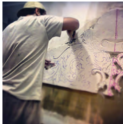
شکل ۳۵-۲- مراحل اجرای گچ‌بری به شیوه درجا
