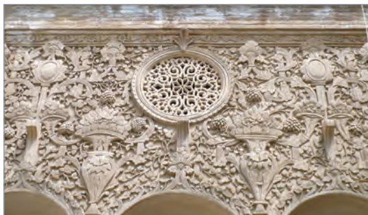
شکل ۲-۲- گچ بری نمای بیرونی
