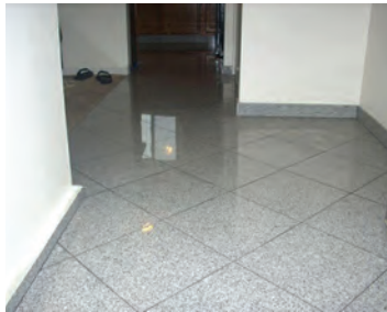
شکل ۳-۴۵- کف سازی نهایی با پوشش اپوکسی گرانیتی شطرنجی
