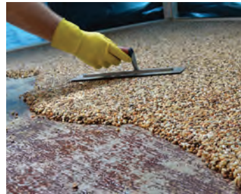
شکل ۳-۴۳- نمایش نحوه پخش و اجرای اپوکسی گرانیتی
