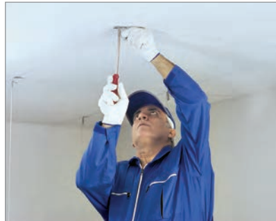
شکل ۱۱۶-۳- اتصال قطعه HT ۹۰ به سقف اصلی شکل ۱۱۷-۳
