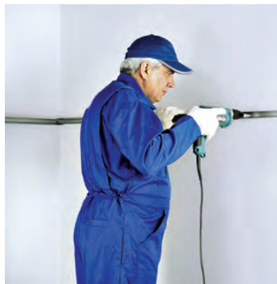
شکل ۳-۴۵- نصب سازه تراز
