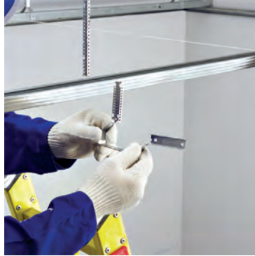
شکل ۳-۵۶- باز کردن رکاب
