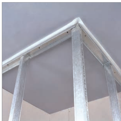
شکل ۸۶-۳- شکل نوار چسب جداکننده پس از نصب سازه‌ها
