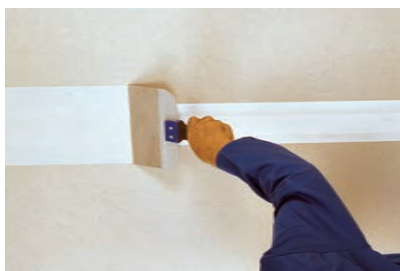
شکل ۸۲-۳- قرار دادن نوار درزگیر بر روی بتونه
