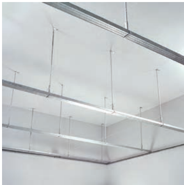
شکل ۳-۵۹- سازه‌های باربر تکمیل شده
