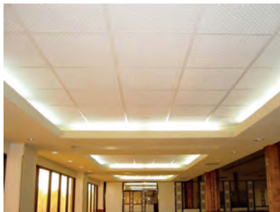
شکل ۱۱۰-۳- اجرای کامل سقف مشبک به روش قرینه‌سازی
