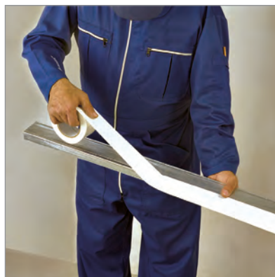
شکل ۸۵-۳- چسباندن نوار ترن فیکس بر روی سازه
