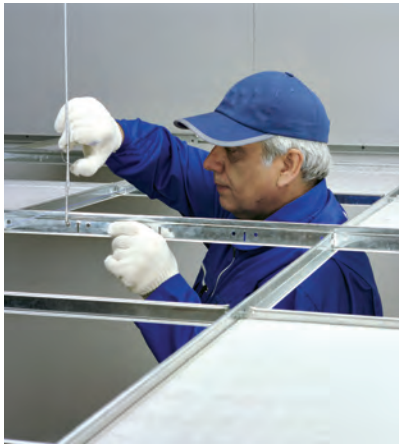
شکل ۱۲۲-۳- تنظیم ارتفاع سقف
