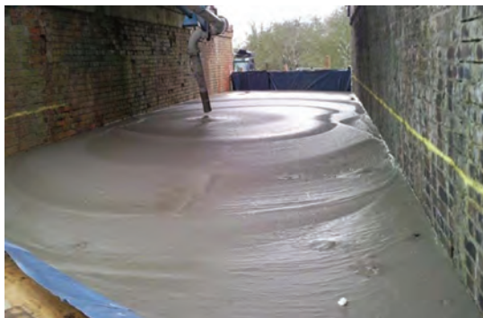
شکل‌های ۴-۵ و ۴-۶- شیبه‌های مختلف اجرای فوم بتن
