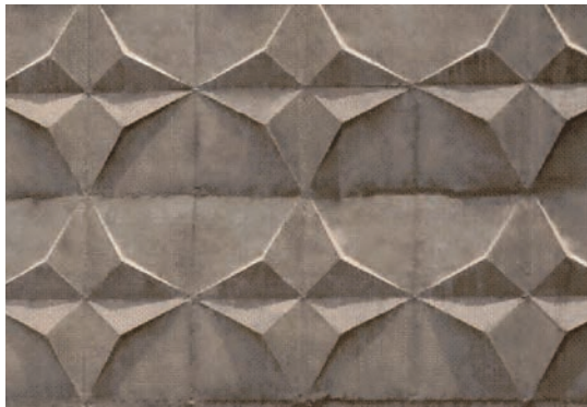
شکل ۴-۱۴- بتن نمایان اجرا شده با قالب طرح دار
