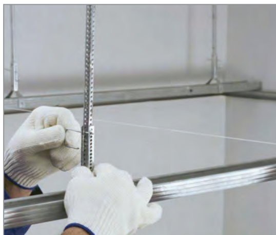
شکل ۴-۱۹- جزئیات و اتصالات شاسی سقف‌های کاذب
