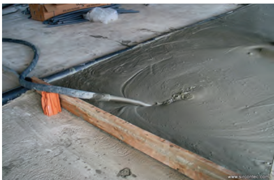
شکل ۴-۷- قالب‌بندی برای اجرای فوم بتن
