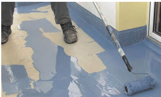
شکل ۴-۱۰- یکی از روش‌های اجرای اپوکسی
