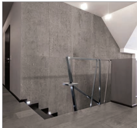
شکل ۴-۱۵- یک جداره داخلی از بتن نمایان قالبی
