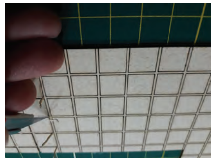
شکل ۹۲-۵- ایجاد شیار روی سقف
