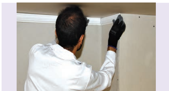
شکل ۲۳۲-۱- نصب قطعه نهایی
