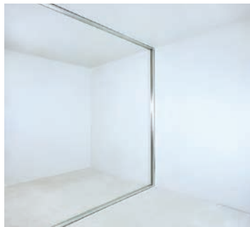
شکل ۷۹-۱- تکمیل قاب پیرامونی اول شکل ۸۰-۱- اجرای قاب پیرامونی دوم
