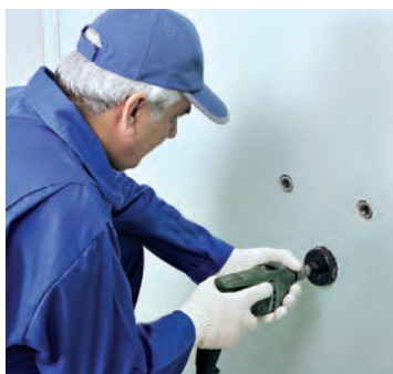
شکل ۱۰۲-۱- ایجاد خروجی تأسیسات به وسیله گرد بر
