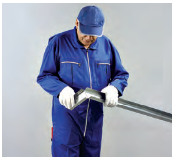
شکل ۴۱-۱- پس از برش بال‌ها، رانر خم و راست شده تا از محل جان برش بخورد.
