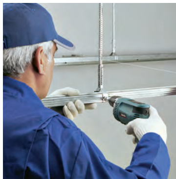
شکل ۳-۵۸- اتصال سازه باربر به رکاب توسط پیچ LN
