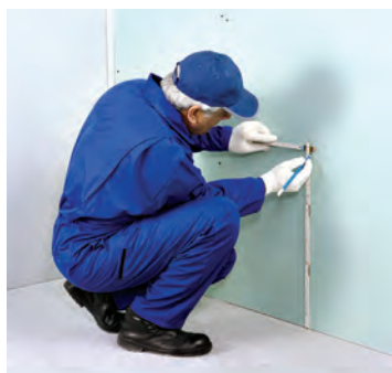
شکل ۱-۱۵۶- تعیین محل خروجی‌های تأسیساتی
