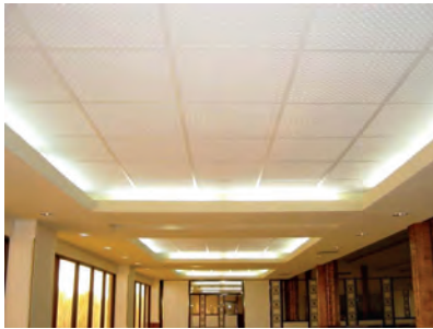
شکل ۱۱۰-۳- اجرای کامل سقف مشبک به روش قرینه‌سازی
