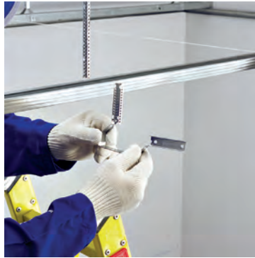
شکل ۳-۵۶- باز کردن رکاب
