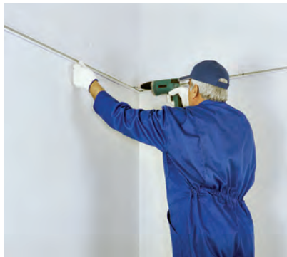
شکل ۳-۱۰۸- نصب سازه تراز پس از تعیین خط تراز سقف
