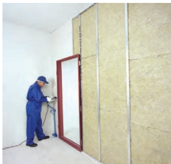
شکل ۱-۱۴۲- پیچ زنی پانل در حاشیه دور چهارچوب
