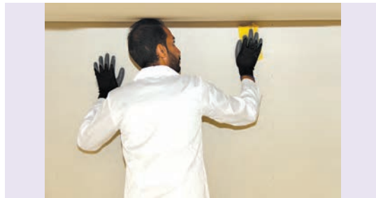
شکل ۲۲۵-۱- تمیز کردن سطح کار
