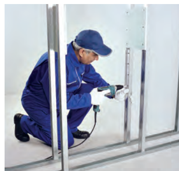
شکل ۱-۱۵۴- اتصال قطعات نشی L25 به استادهای مجاور
