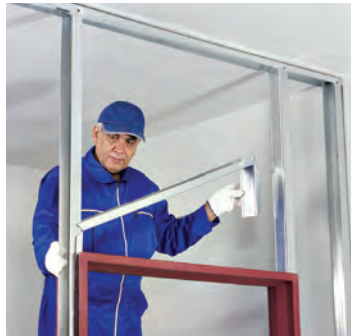
شکل ۱۲۹-۱- استقرار رانر نعل درگاه
