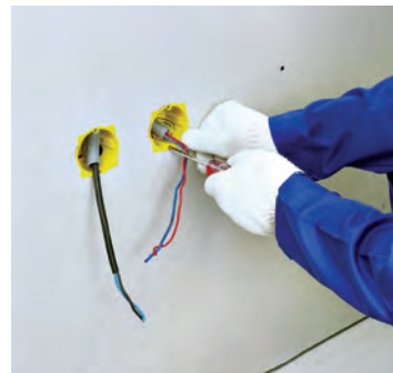
شکل ۱۷۶-۱- گیره‌ها توسط پیچ گوشتی جمع می‌شوند.
