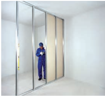
شکل ۱-۶۲- اجرای پانل‌ها در یک طرف دیوار
