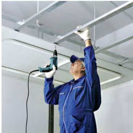
شکل ۳-۶۷ اتصال پانل به زیرسازی توسط پیچ
