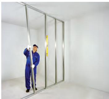
شکل ۱-۵۴ - اجرای استادها ( به صورت شاقولی)
