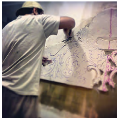
شکل ۳۵-۲- مراحل اجرای گچ‌بری به شیوه درجا
