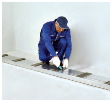
شکل ۸۲-۱- برش نوارهای عایق
