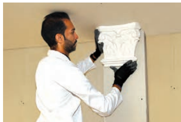
شکل ۲۴۲-۱- اتصال قطعه اول به ستون
