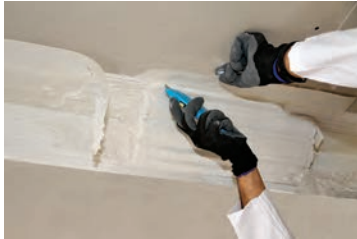
شکل ۲۳۹-۱- تمیز کردن اطراف کار
