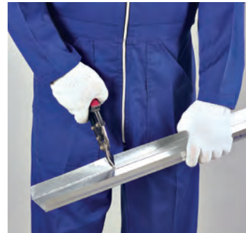
شکل ۱۱۳-۱- برش انتهای رانرهای کف
