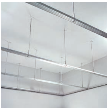
شکل ۳-۵۹- سازه‌های باربر تکمیل شده
