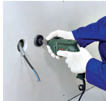
شکل ۱۷۳-۱- خروجی‌های تأسیساتی به وسیله گردبر ایجاد می‌شوند.
