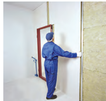
شکل ۱۴۳-۱- اجرای پانل چهارم دور چهارچوب
