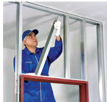
شکل ۱۳۱-۱- استقرار استادهای کتیبه
