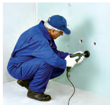
شکل ۱-۱۵۷- ایجاد خروجی‌های تأسیساتی به وسیله گردبر
