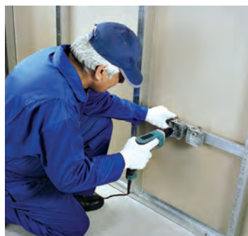
شکل ۱-۱۶۹- اتصال قوطی برق به سازه پشتیبان
