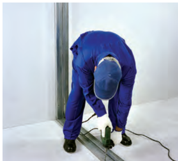
شکل ۷۹-۱- تکمیل قاب پیرامونی اول شکل ۸۰-۱- اجرای قاب پیرامونی دوم
