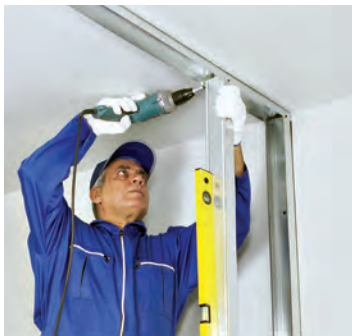
شکل ۱۱۸-۱- اتصال بالای استاد با پیچ LB
