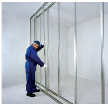
شکل ۱-۹۶- شاقولی کردن ردیف اول استادها
