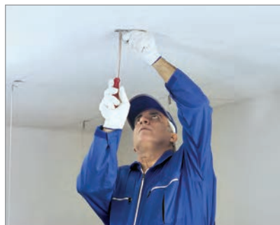
شکل ۱۱۶-۳- اتصال قطعه HT ۹۰ به سقف اصلی شکل ۱۱۷-۳
