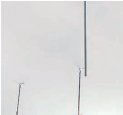
شکل ۴۸-۳ تکمیل شدن آویزها
