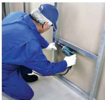
شکل ۱-۱۶۸- اتصال سازه پشتیبان به استادهای مجاور
