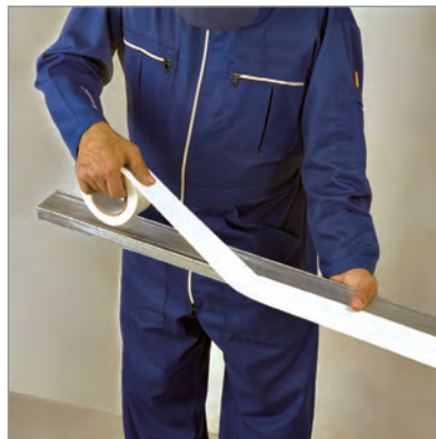
شکل ۸۵-۳- چسباندن نوار ترن فیکس بر روی سازه
