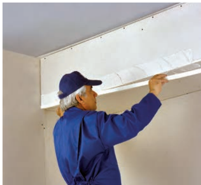
شکل ۸۴-۳- قرار دادن نوار درزگیر بر روی بتونه
