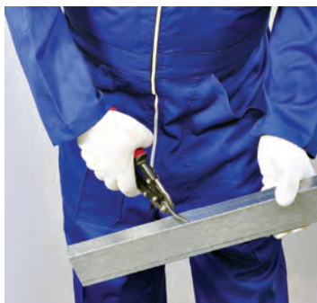
شکل ۱۲۵- چهارچوب توسط پیچ LB در محل صفحات به استادها متصل می‌شود. شکل ۱۲۶- علامت‌گذاری انتهای رانر نعل درگاه به صورت فارسی بر ( به اندازه ۲۰ سانتی‌متر) شکل ۱۲۷- برش انتهای رانر نعل درگاه
