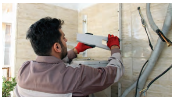
شکل ۷- نصب یونیت خارجی
