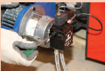
هواگیری پمپ
