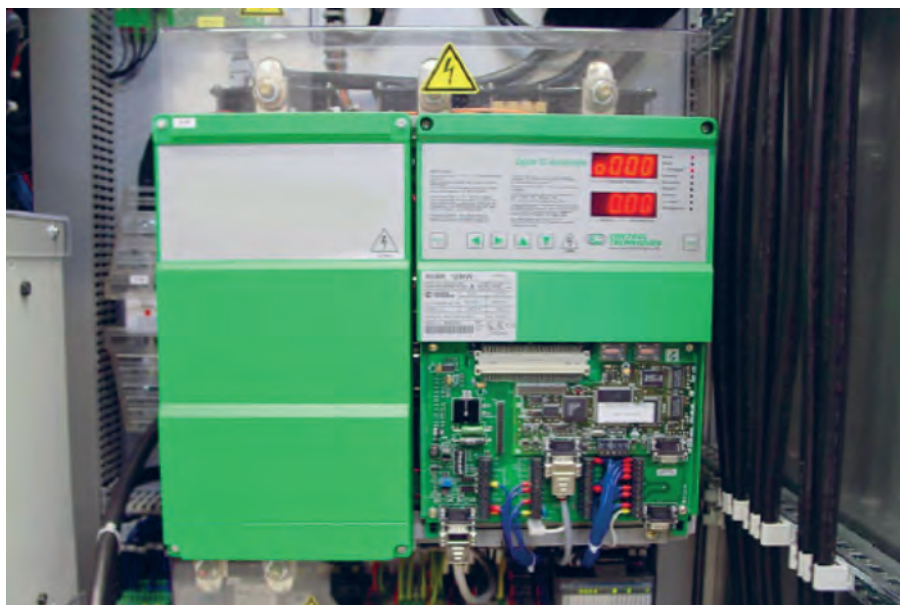
شکل ۴۴- یک دراپور برای راه‌اندازی و کنترل موتور اصلی دستگاه چاپ
