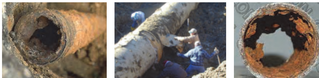
شکل ۴- نمونه‌ای از خوردگی لوله‌های دفن شده
