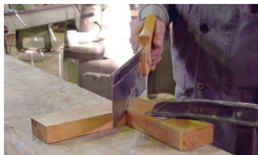
شکل ۲۱- چگونگی اَره‌کشی درز بین اتصال
