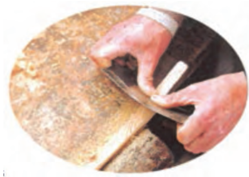
شکل ۵۶- استفاده صحیح از لیسسه
