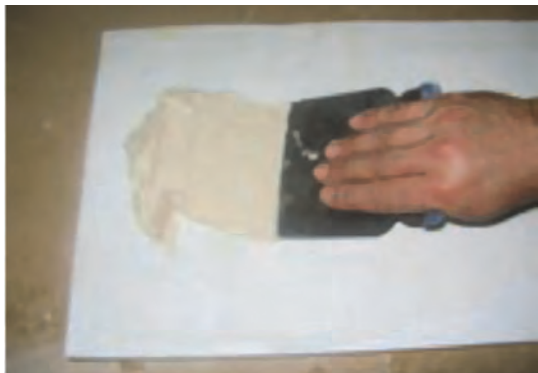
شکل ۹۱- ساخت بتونه سریشی
