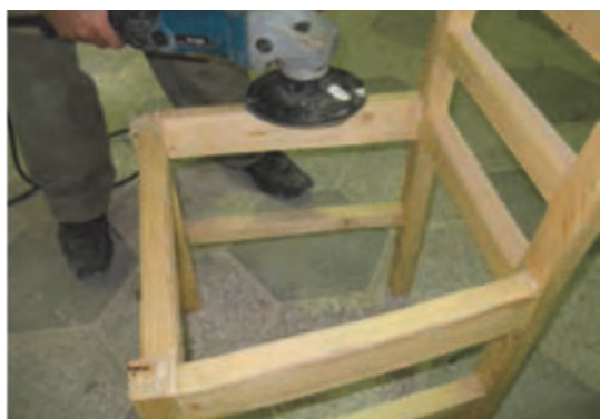
شکل ۷۲- پرداخت کاری قبل از بتونه
