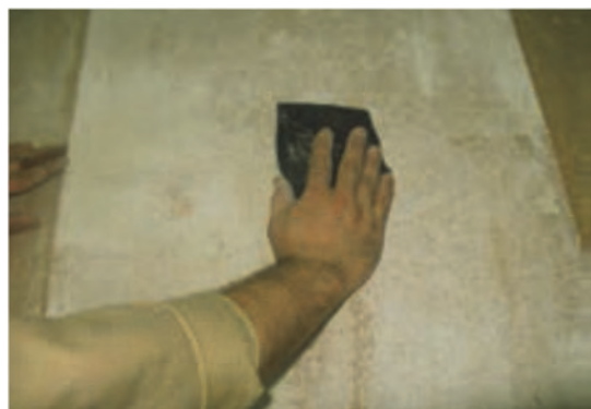
شکل ۸۰- سنباده کاری روی سطح بتونه سریشی
