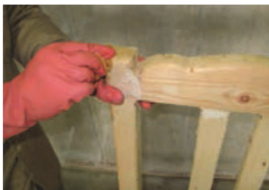
شکل ۷۱- بتونه کاری غیر پوششی
