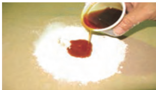
شکل ۸۶- اضافه نمودن رنگ روغنی به بتونه روغنی
