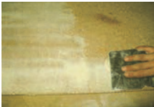
شکل ۷۳- استفاده از بتونه رقیق
