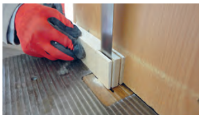
شکل ۹۰- عملیات برش زبانه با دستگاه اره نواری
