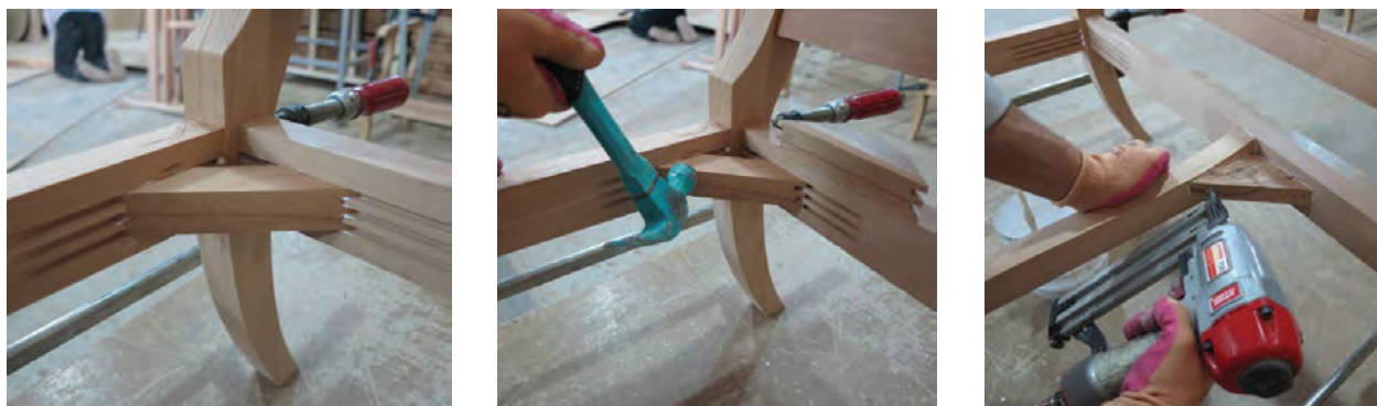
شکل ۵۸- جا زدن نشی‌های گوشه
