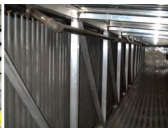
شکل ۳۸- نحوه قرارگیری کویل‌های حرارتی
