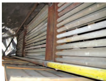
شکل ۳۸- نحوه قرارگیری کویل‌های حرارتی
