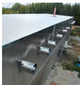
شکل ۴۳- نصب دمنده در خارج از کوره
