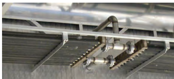
شکل ۴۱- انتقال حرارت کویل‌ها با هوای اطراف خود
