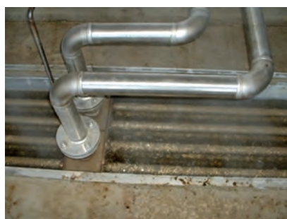
شکل ۶۱- کویل‌های حرارتی برای گرم کردن هوای کوره
