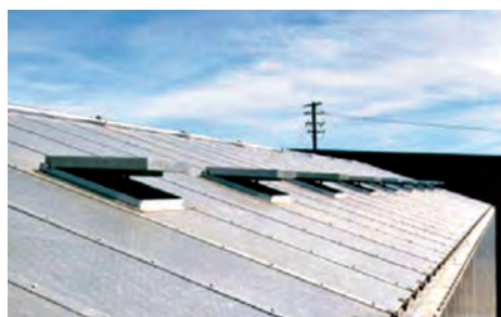
شکل ۴۴- دریچه‌های تخلیه هوا
