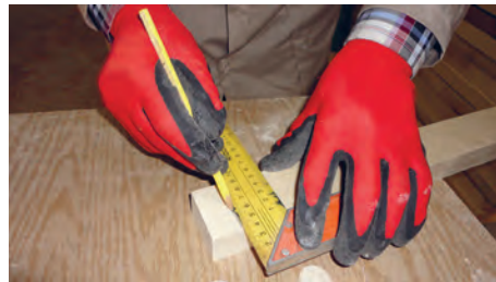
شکل ۸۷- علامت زدن قطعات مختلف برای انجام اتصال
