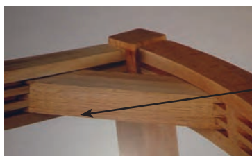
شکل ۲۰- بلوک سه گوش (نبشی) با اتصال انگشتی
