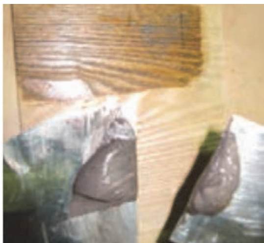
شکل ۱۳۸- برداشتن بتونه
