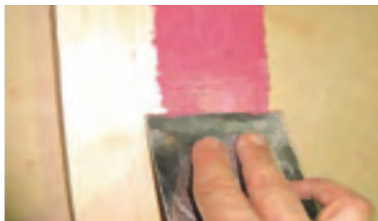
شکل ۹۲- ماستیک کاری با بتونه روغن رنگ قرمز
