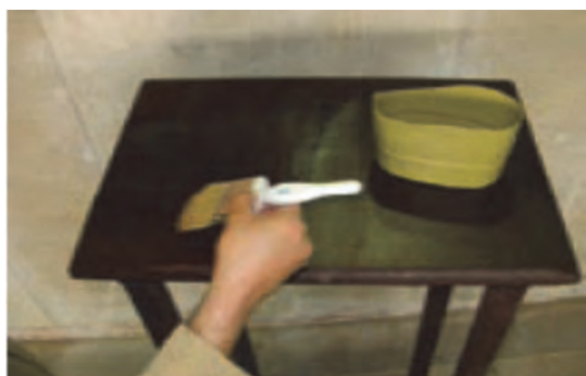
شکل ۳۱- زدن سیلر با قلم مو روی سطح آستر خورده
