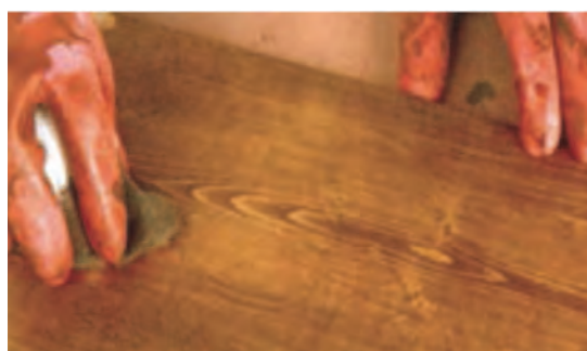
شکل ۱۴۴- زدن آستری هم رنگی با پارچه
