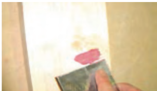
شکل ۹۳- لکه گیری قبل از ماستیک کاری
