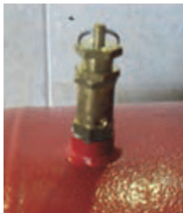
شکل ۱۸۹- سوپاپ کمپرسور برای خروج هوای اضافی
