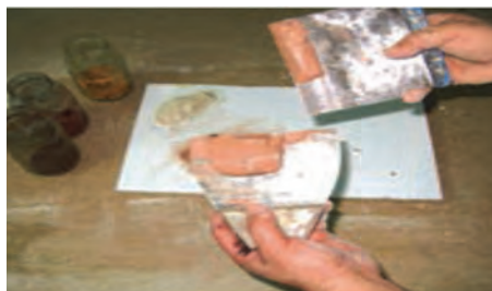
شکل ۴۶- ساخت بتونه هم‌رنگی
