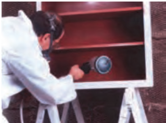
شکل ۲۳- رنگ کاری قسمت‌های داخلی
