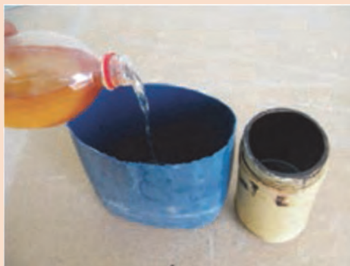
شکل ۷- رقیق کردن آستری قیری با بنزین
