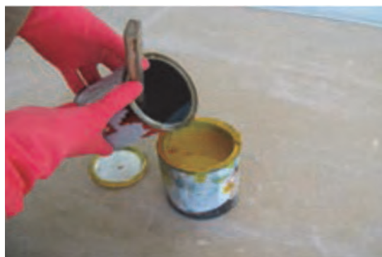
شکل ۸۵- اضافه کردن روغن جلا به رنگ روغنی
