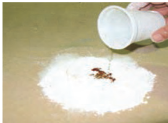
شکل ۷۸- اضافه نمودن آب به بتونه روغنی
