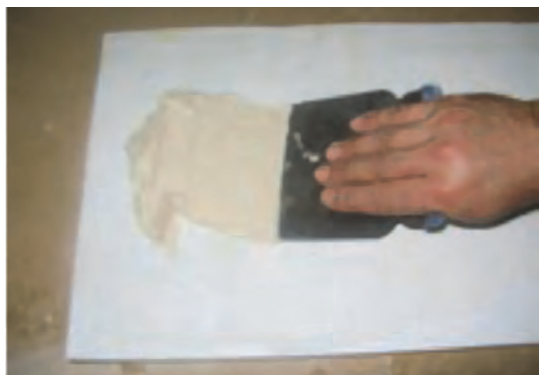
شکل ۹۱- ساخت بتونه سریشی
