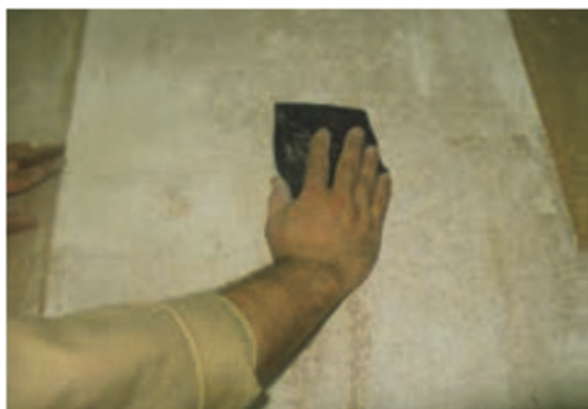
شکل ۸۰- سنباده‌کاری روی سطح بتونه سریشی
