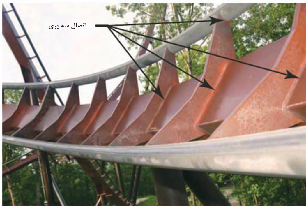
شکل ۱۲- کاربرد اتصال سه پری
