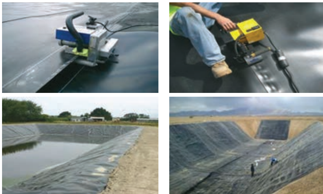
شکل ۱۵- جوشکاری عایق‌های پلاستیکی (ژئوممبران) استخرهای ذخیره آب
