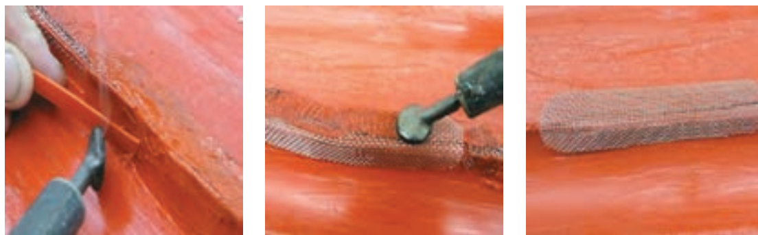
شکل ۳۰- استفاده از توری فلزی در تعمیر قطعات پلاستیکی
