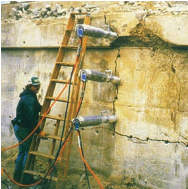
ابزار برش هیدرولیک سنگ
