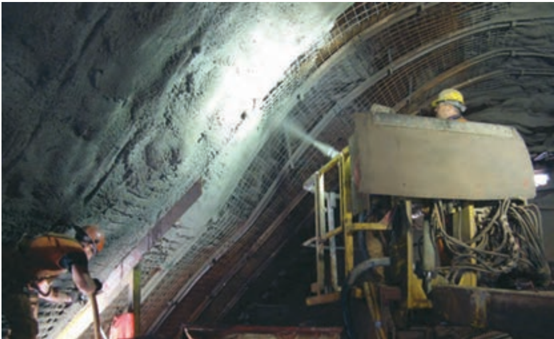
نگهداری به کمک پیچ سنگ، تور سیمی و تزریق سیمان در تونل اصلی معدن
