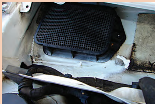
شکل ۲۰- اثر گرفتگی مجرا و عدم تخلیه آب
