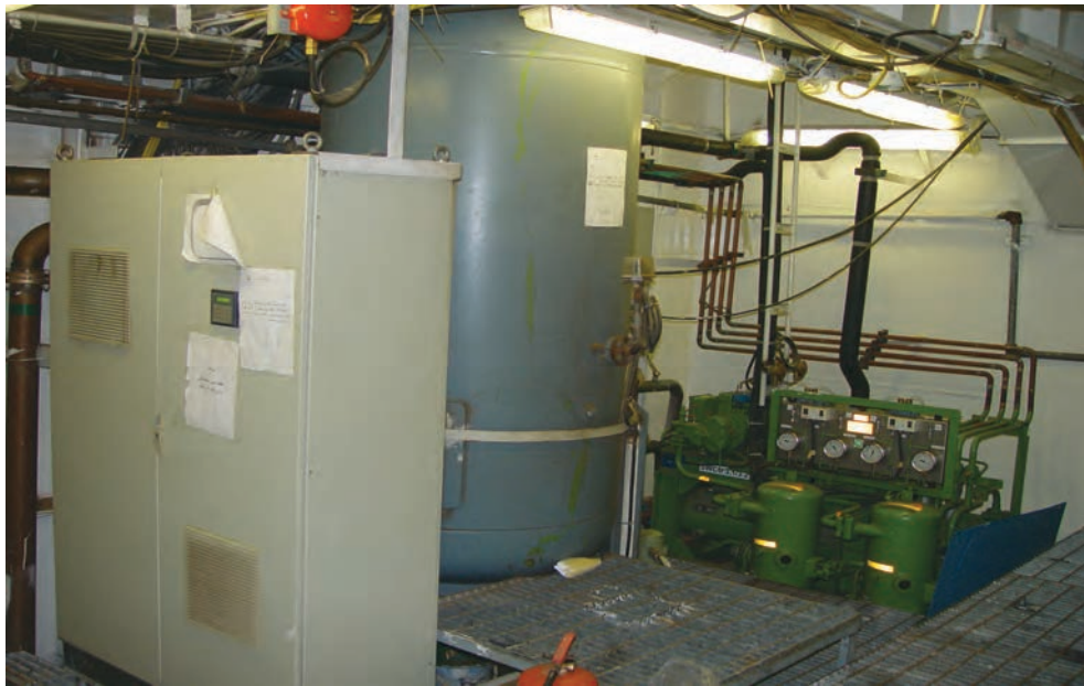
شکل ۱۷- سامانه هوای فشرده
