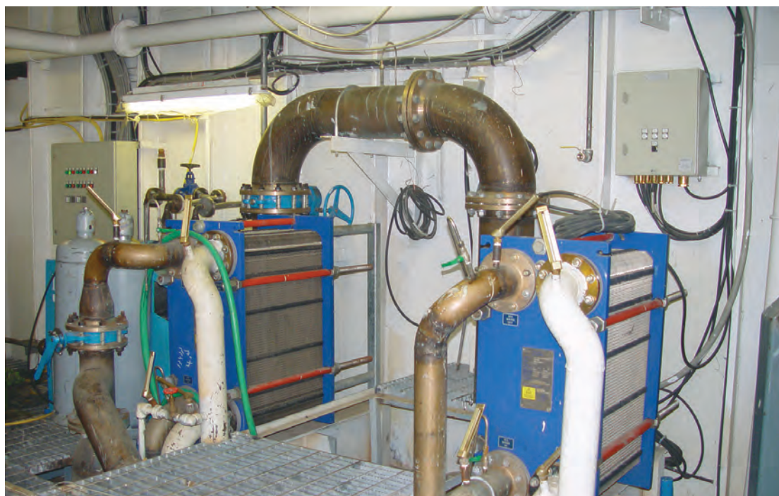
شکل ۶- سامانه خنک کاری آب دریا
