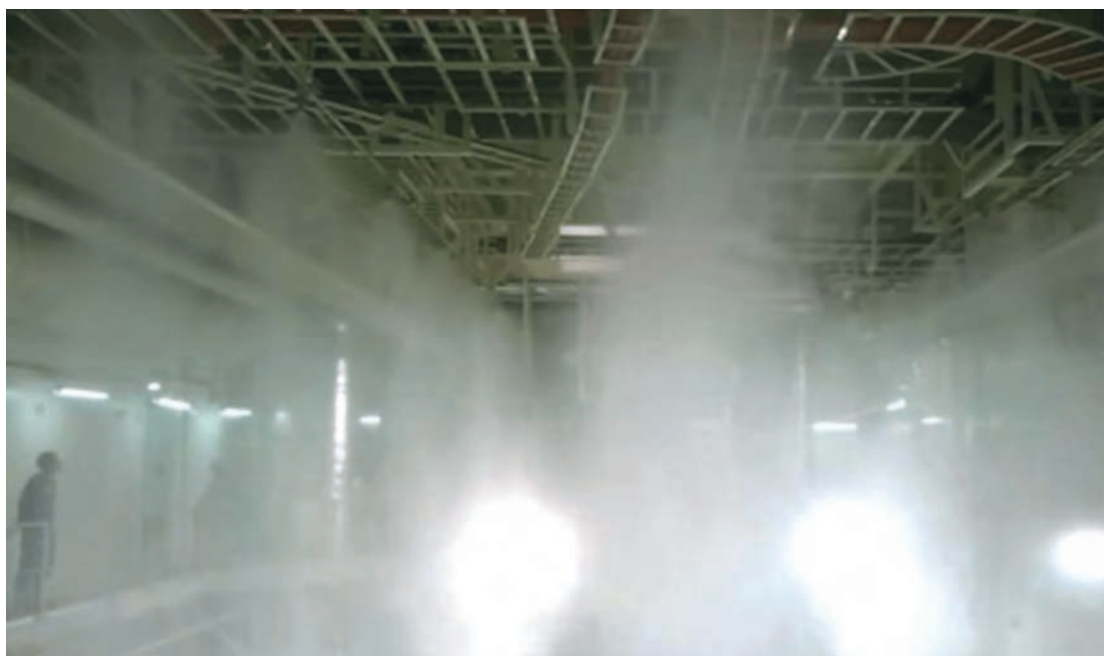
شکل ۱۶- عمل کردن حسگرها در موتورخانه یک کشتی
