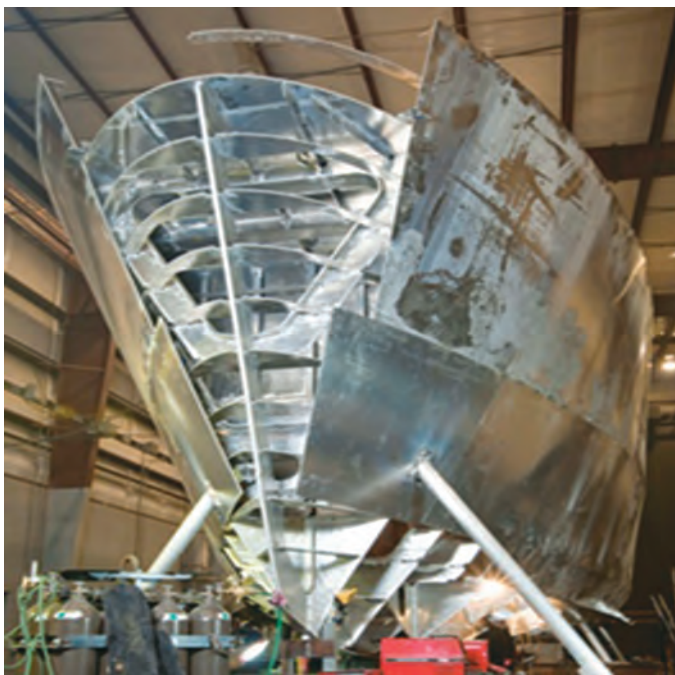
شکل ۲۳- سازهٔ سینهٔ یک شناور در حال ساخت
