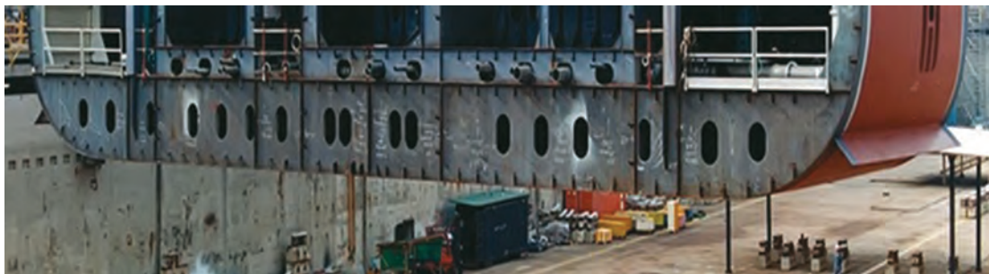
شکل ۱۴- کف دو جداره یک کشتی در حال ساخت
