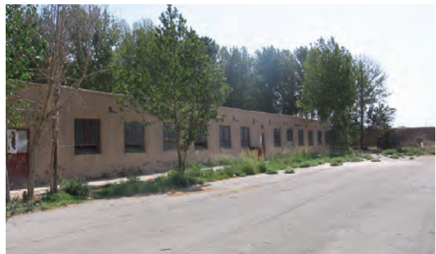
تصویر ۸-۱- پنجره‌ی دیوار جلویی (جنوبی)
