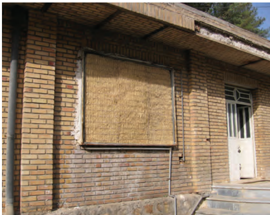
تصویر ۱۳-۲- انواع سیستم پوشال و هواکش
