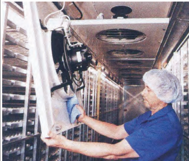
تصویر ۲۱-۴- سرویس دستگاه‌های تهویه
