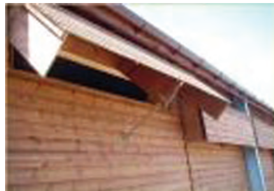
تصویر ۱۴-۲ - انواع دریچه‌های ورود هوا
