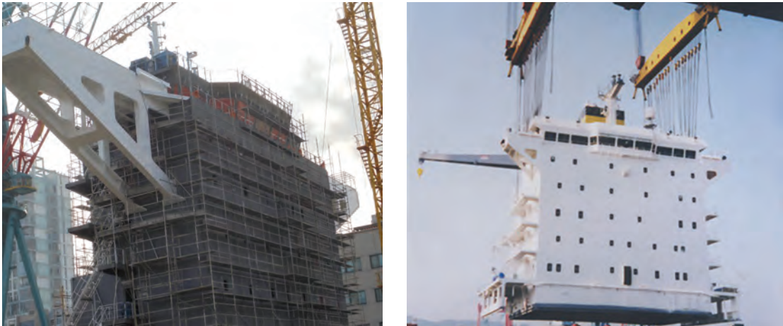
شکل ۱۶- ساختمان محل استراحت خدمه و پل فرماندهی
