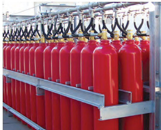
شکل ۳۸- سامانه اطفای حریق CO 2
