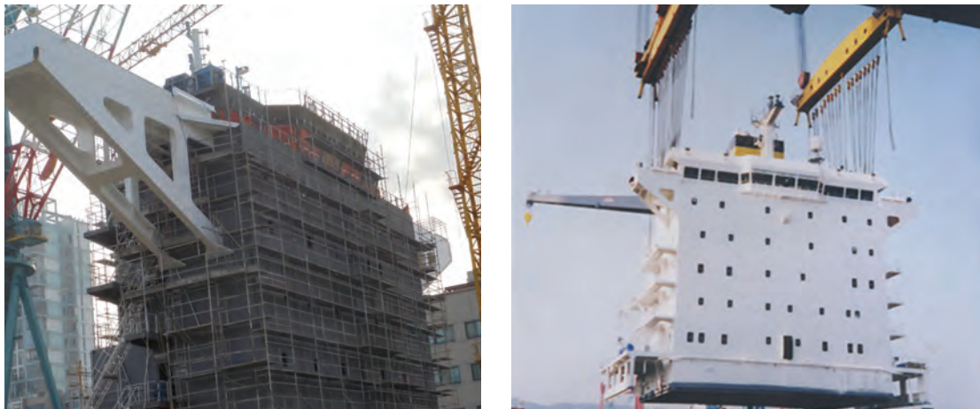
شکل ۱۶- ساختمان محل استراحت خدمه و پل فرماندهی
