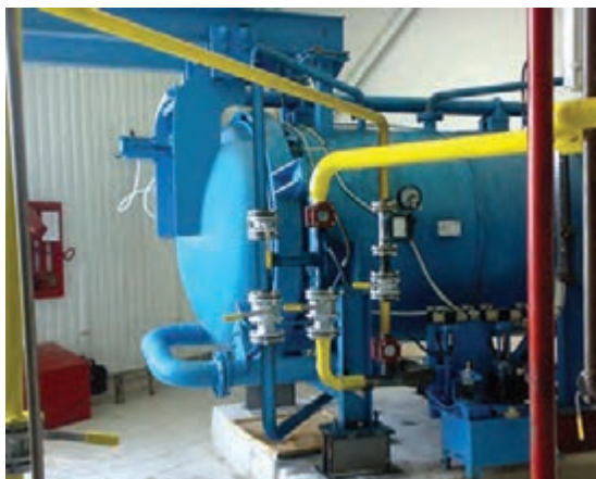
شکل ۱۲- سیستم زمستانه کردن روغن ها
