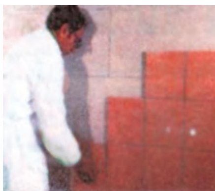
شکل ۱ - ۴۳: نصب کاشی روی قطعات پیش ساخته گچی
