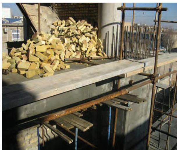
شکل ۱-۲: ضخامت مناسب برای تخته زیر پایی
