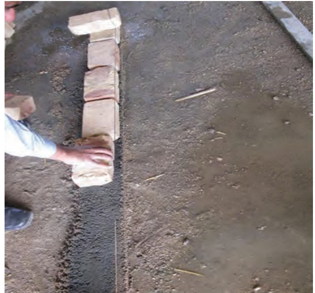
شکل ۱ - ۹۱ : نحوه چیدن آجر در امتداد ریسمان کار
