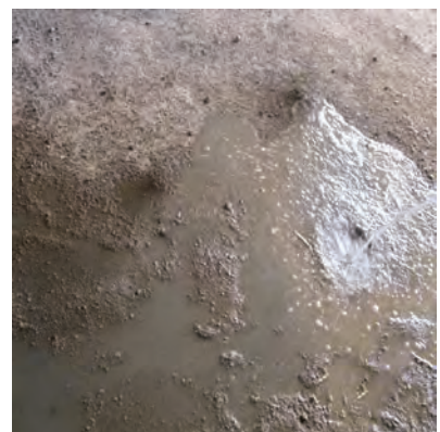
شکل ۱- ۱۰۳: خیس کردن سطح زیر کار
