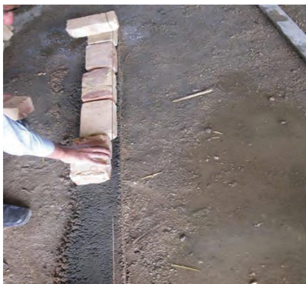
شکل ۱- ۷۴: نحوه چیدن آجر در امتداد ریسمان کار
