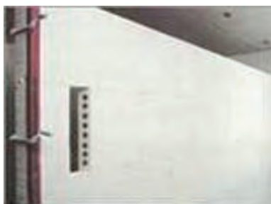
شکل ۱ - ۳۷: دیوار جداکننده با قطعات پیش ساخته گچی
