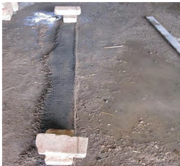
شکل ۱- ۷۳: بادخور نمودن ریسمان کار
