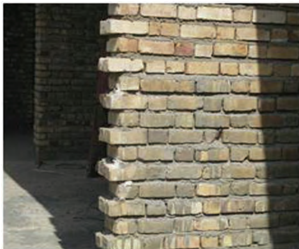
شکل ۱-۵۲: لابند در دیوار آجری
