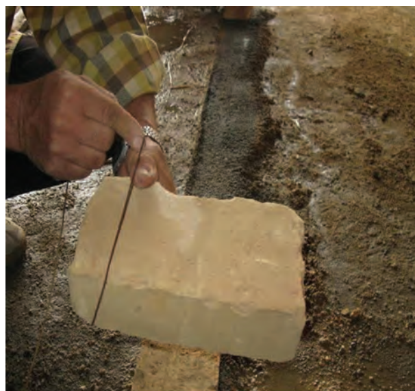
شکل ۸۹-۱: نحوه بستن ریسمان کار به آجر
