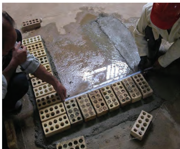
شکل ۱ - ۳۳ (الف): برداشتن طول دیوار
