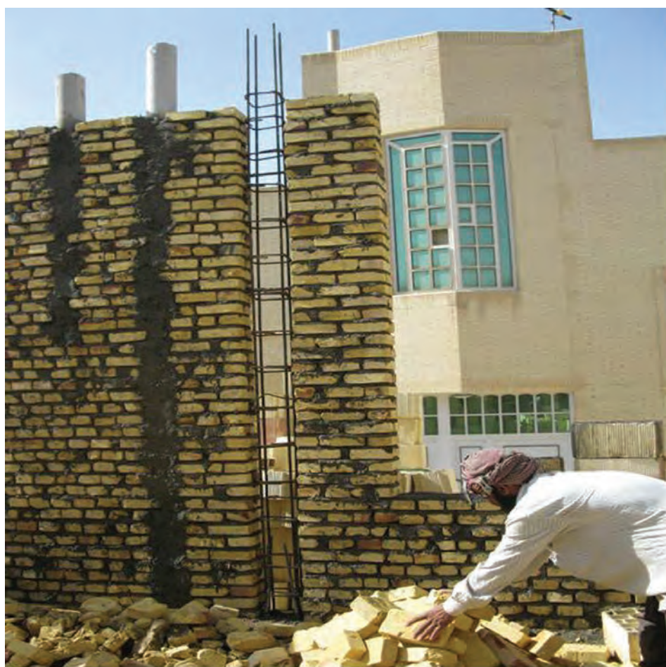
شکل ۱ - ۶۰: اتصال کلاف قائم و افقی در دیوار
