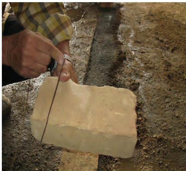
شکل ۱- ۷۲: نحوه بستن ریسمان کار به آجر
