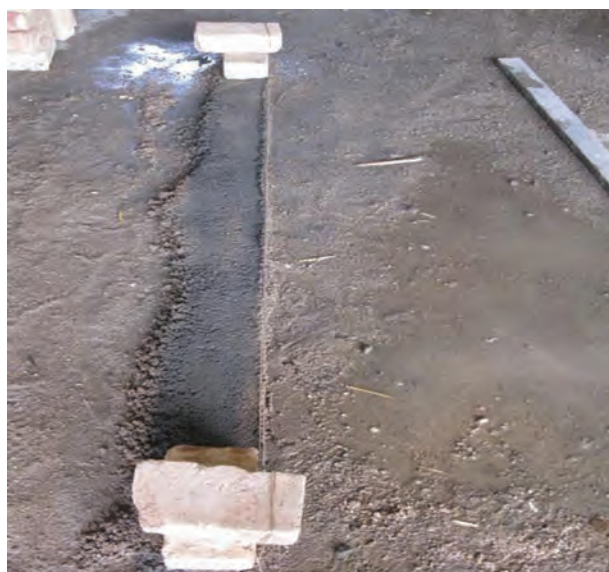
شکل ۹۰-۱: بادخور نمودن ریسمان کار
