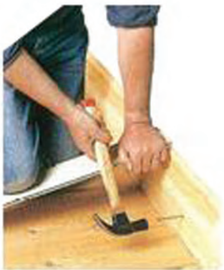
شکل ۳- ۲۹: نصب قرنیز چوبی با میخ
