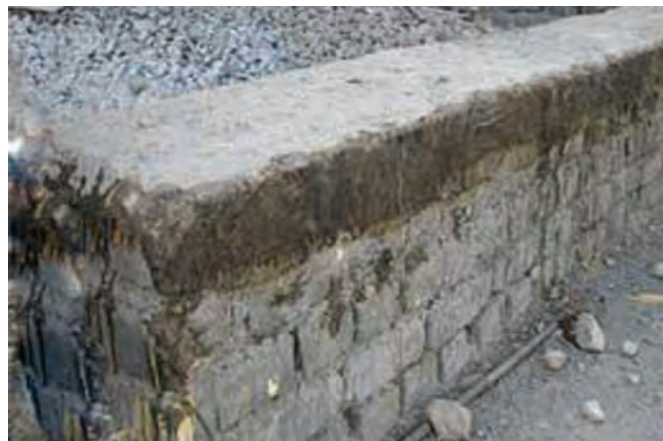
شکل ۱ - ۲۹ : کرسی چینی یا عایق کاری رطوبتی
