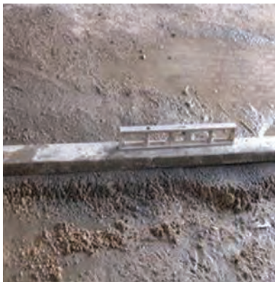
شکل ۱- ۱۰۵: تراز کردن روی ملات
