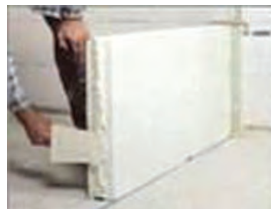
شکل ۱ - ۳۶: طریقه نصب بلوک های گچی
