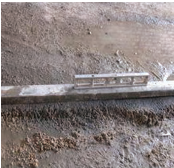
شکل ۱ - ۸۶: کنترل تراز سطح ملات
