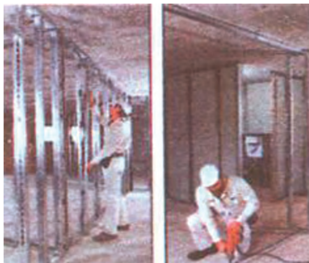
شکل ۱-۴۴: قاب سازی جهت اتصال روکش های گچی
