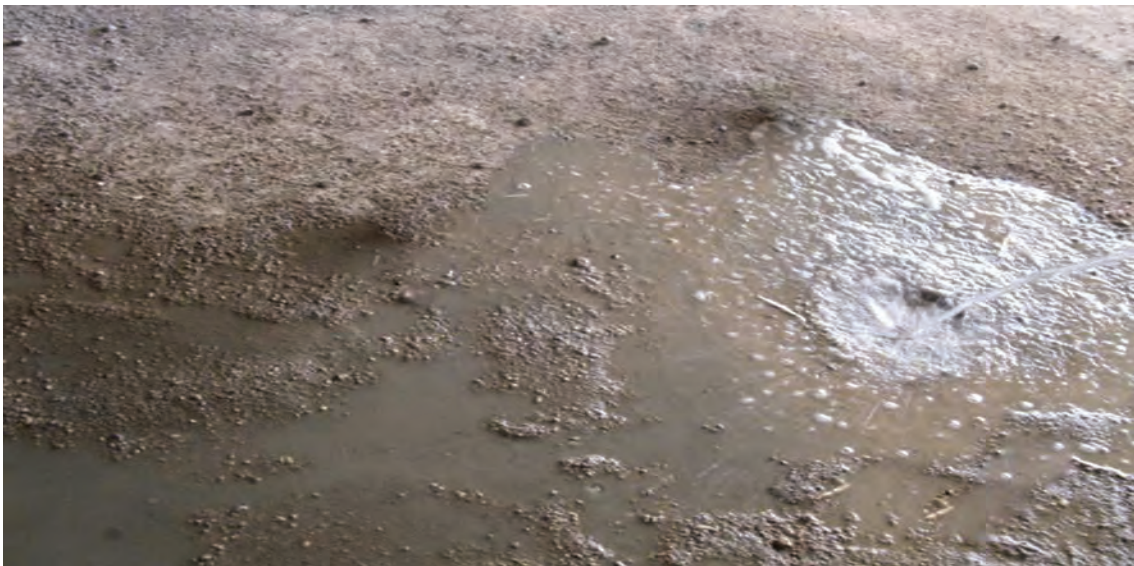
شکل ۱ - ۶۷: خیس کردن سطح زیر کار
