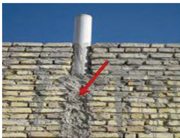
شکل ۱ - ۶۵: پر کردن درز لوله‌ها
