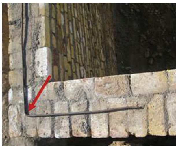
شکل ۱- ۵۵: میلگرد گذاری در محل اتصال دو دیوار
