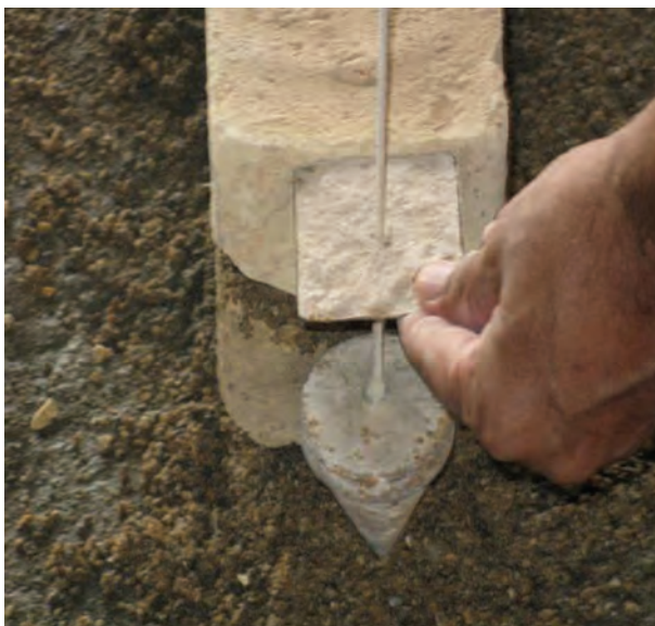
شکل ۱ - ۹۴ : شاقول کردن نبش کار
