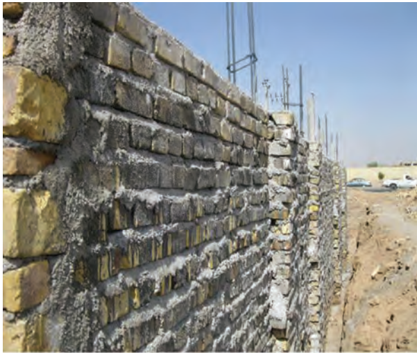
شکل ۱ - ۲۶: دیوار آجری با کلاف بندی قائم
