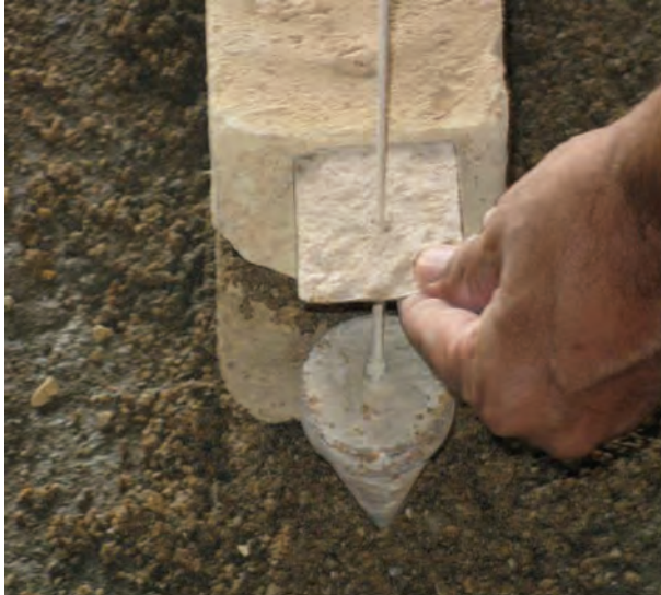
شکل ۱- ۷۷: شاقول کردن نبش کار
