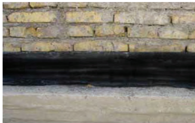
شکل ۱ - ۳۰ : دیوار روی کرسی چینی
