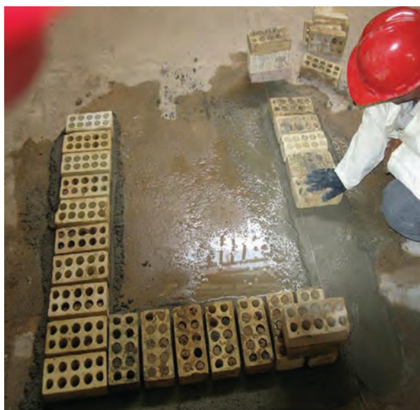
شکل ۱ - ۳۳ (ج): ریسمان کشی و چیدن ضلع سوم
