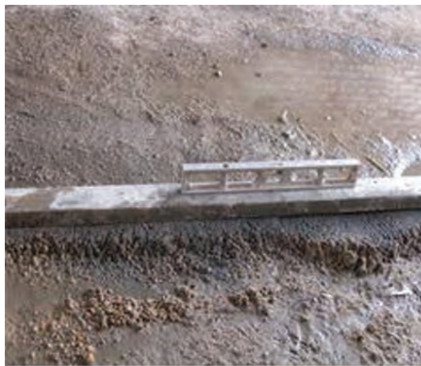
شکل ۱- ۶۹: تراز کردن روی ملات
