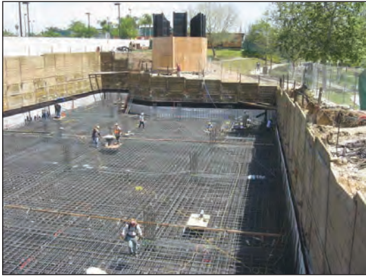
شکل ۳-۶۸ پی بتن مسلح یکپارچه (رادیه ژنرال)
