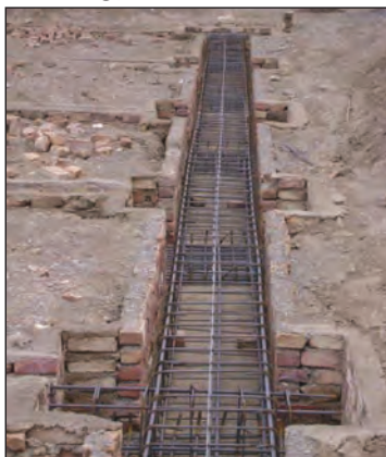
شکل ۳-۱۳۶ پی و شناژ قبل از بتن‌ریزی
