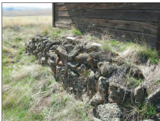
شکل ۳-۴۰ پی سنگی با سنگ لاشه
