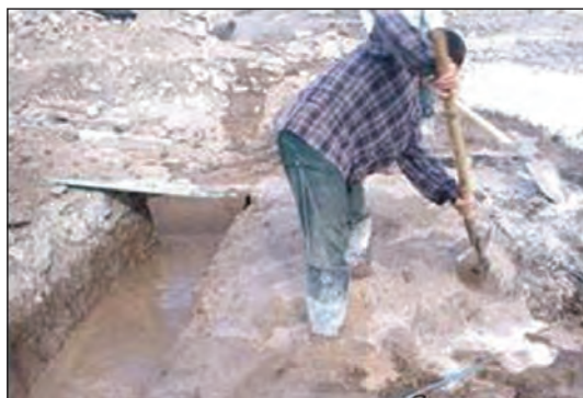
شکل ۳-۳۷ اجرای شفته آهک در فونداسیون
