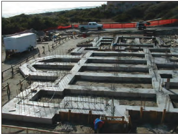
شکل ۳-۶۲ پی بتن مسلح نواری شبکه ای زیرستون
