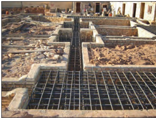
شکل ۳-۱۳۴ میلگردگذاری در پی کلاف بندی
