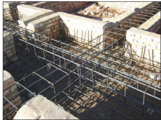
شکل ۳-۱۳۵ عبور میلگردهای شناژ در پی
