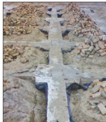
شکل ۳-۱۳۷ پی و شناژ بعد از بتن‌ریزی
