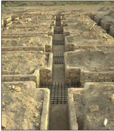
شکل ۳-۵۴ آرماتورگذاری پی تکی کلاف بندی شده
