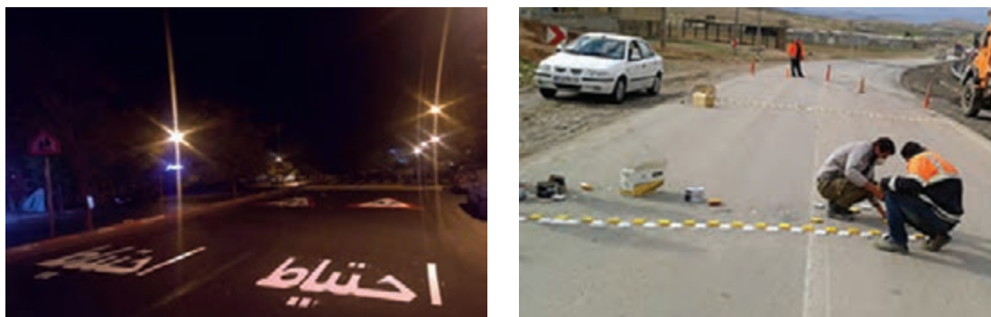
شکل ۲۹- نمونه‌ای از شیوه هشدار برای نزدیک شدن به گذرگاه برجسته عابر پیاده
