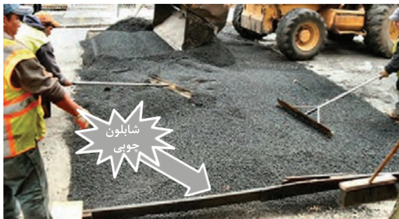
شکل ۲۳- اجرای سرعت‌گاه آسفالتی
