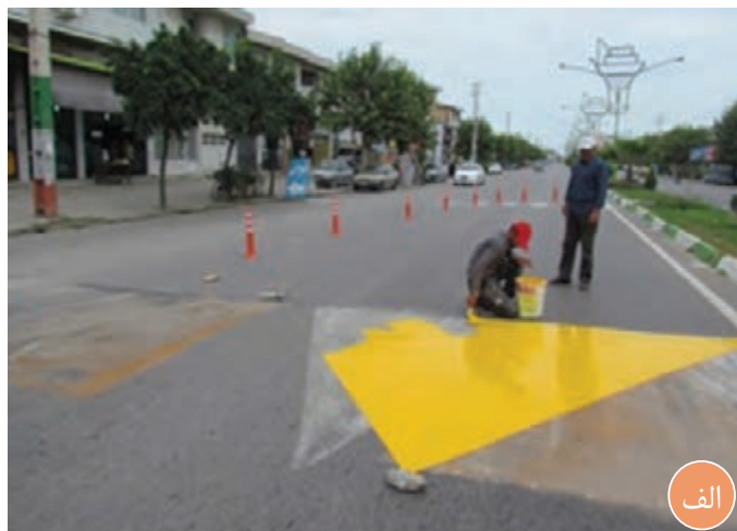
شکل ۲۷- رنگ‌آمیزی سطح روسازی
