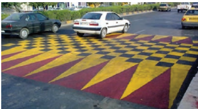
شکل ۲۵- نمونه‌ای از نحوه خط‌کشی سرعت‌کاه
