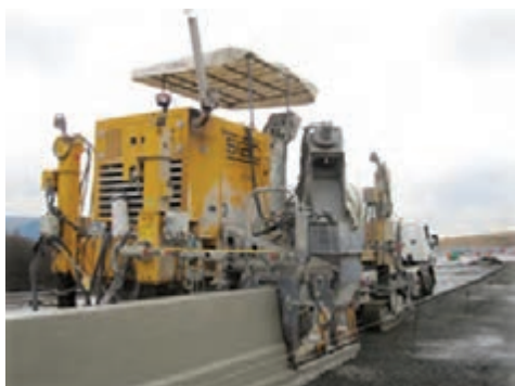
شکل ۵۰- ساخت نیوجرسی (بتن درجا به روش اتوماتیک)
