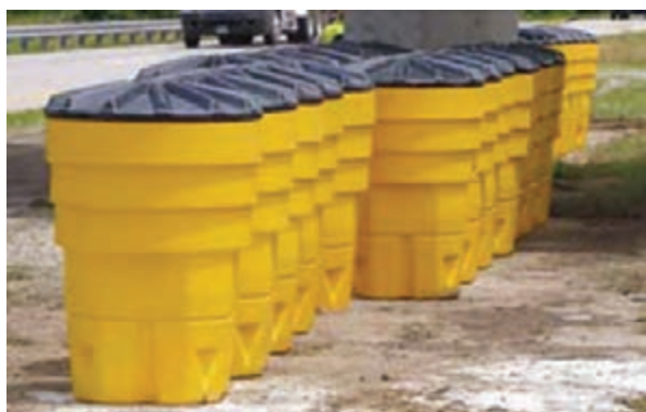
شکل ۲۷- طریقه نصب و چیدمان صحیح ضربه‌گیرهای بشکه‌ای
