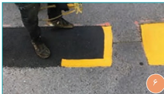
شکل ۷- مراحل اجرای سرعت گیر آسفالتی
