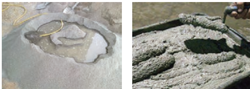
شکل ۱۸- طرز تهیه ملات ماسه سیمان
