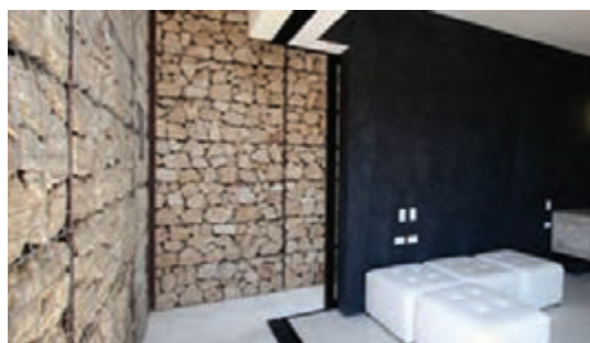
شکل ۵- دیوارهای توری سنگی (گابیون) نمای داخلی (غیرسازه‌ای)
