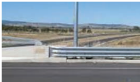
شکل ۸۲ - ناحیه انتقالی حفاظ سه موج به نیوجرسی
