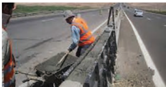
شکل ۲۳- تعمیر حفاظ بتنی (نیوجرسی) در محل
