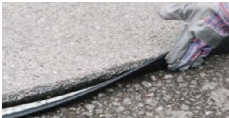
شکل ۴۸- نصب نوار لکه‌گیری بر روی دیواره آسفالت
