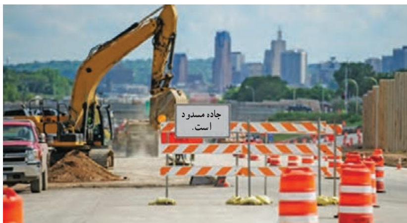
شکل ۳- حفاظت از جان کارگران و ماشین‌آلات با استفاده از علائم هشداردهنده و ضربه‌گیرها در محوطه کارگاهی
