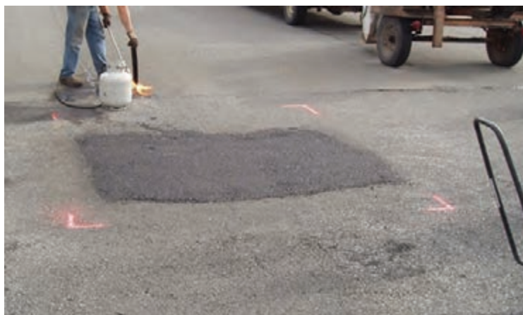
شکل ۳۹- نحوه مشخص کردن محدوده خرابی برای لکه‌گیری
