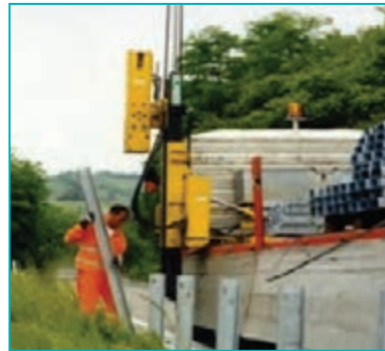
شکل ۳۴- چکش هیدرولیکی گاردریل کوب
