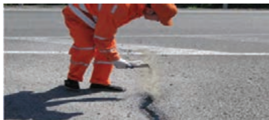
شکل ۲۸- پخش ماسه با استفاده از دست یا بیل بر روی ماده درزگیر
