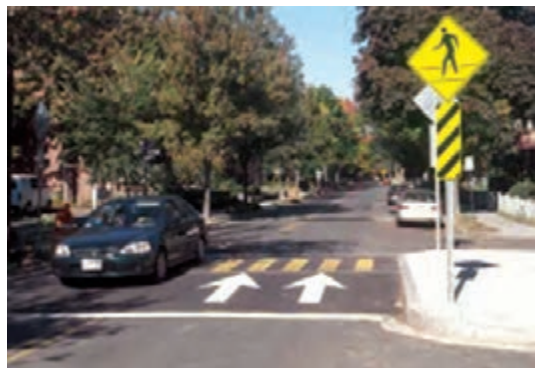
شکل ۲۰- نمونه‌ای از گذرگاه برجسته عابر پیاده
