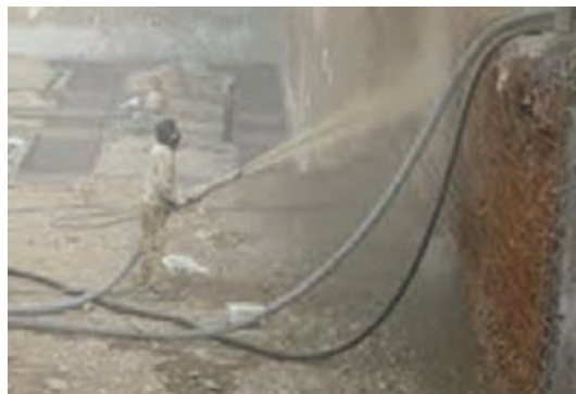
شکل ۲۰- اجرای بتن پاشی (شاتکریت) در بدنه سد
