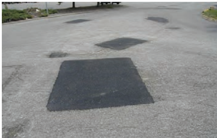
شکل ۹- نمونه‌ای از لکه‌گیری در روسازی آسفالتی
