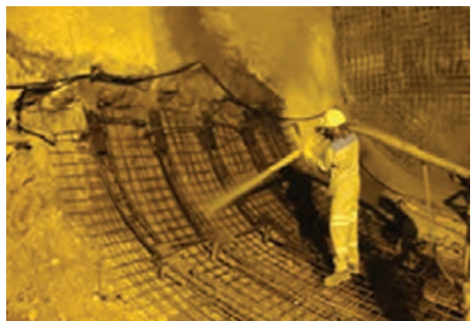
شکل ۲۱- اجرای بتن باشی (شاتکریت) در بدنه تونل نیایش تهران
