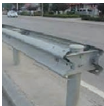
شکل ۱۰- فاصله انداز دوطرفه اجرا شده (ضربه گیر)
