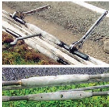
شکل ۴۸ - تنظیم کشش کابل
