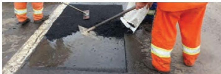
شکل ۳۶- عملیات لکه‌گیری
