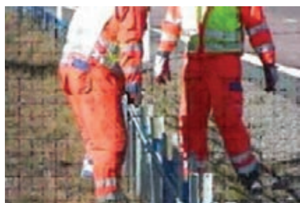
شکل ۶۷- تعمیر حفاظ کابلی
