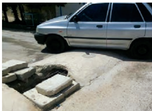
شکل ۹- ساخت سرعت‌گیر غیر استاندارد بتنی و آسفالتی
