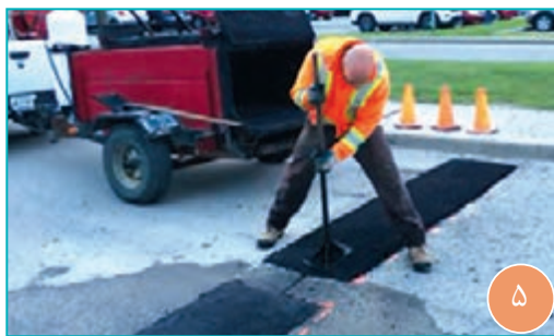
شکل ۷- مراحل اجرای سرعت گیر آسفالتی
