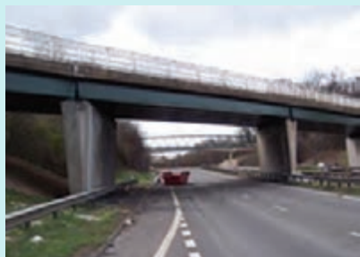
شکل ۷۸- ایمن سازی پایه های پل
