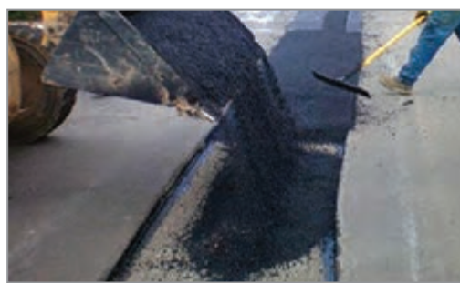
شکل ۴۰- روش ریختن و غلتک زدن
