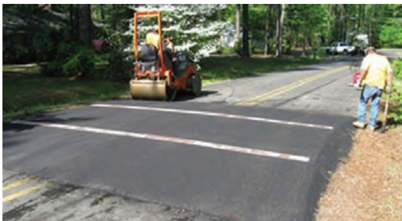
شکل ۲۴- غلتک زدن سطح سرعت‌گاه
