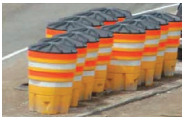
شکل ۲۷- طریقه نصب و چیدمان صحیح ضربه‌گیرهای بشکه‌ای
