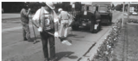
شکل ۲۸- پخش ماسه با استفاده از دست یا بیل بر روی ماده درزگیر
