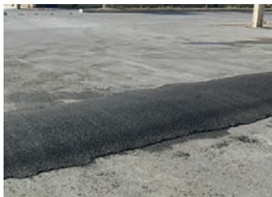
شکل ۹- ساخت سرعت‌گیر غیر استاندارد بتنی و آسفالتی
