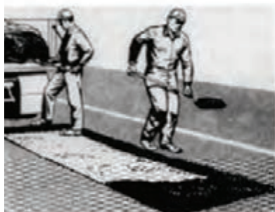
پر کردن محدوده لکه گیری با آسفالت
