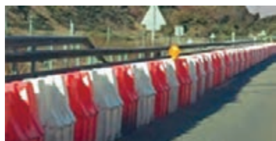
شکل ۲۹- حفاظ پلاستیکی نصب شده در مسیر
