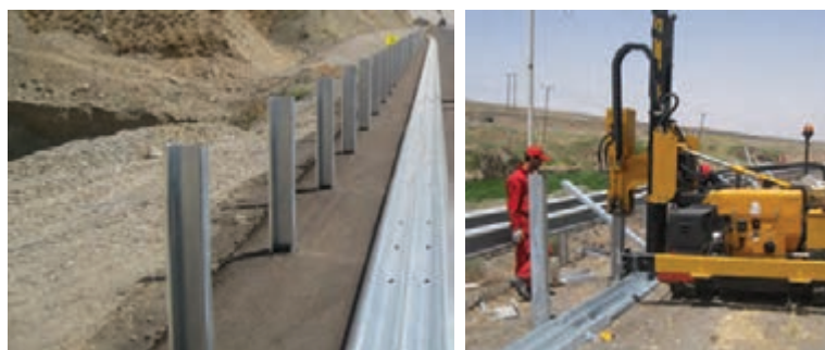
شکل ۴۲- پایه‌کوبی بعد از ریلی کردن سپری‌ها
