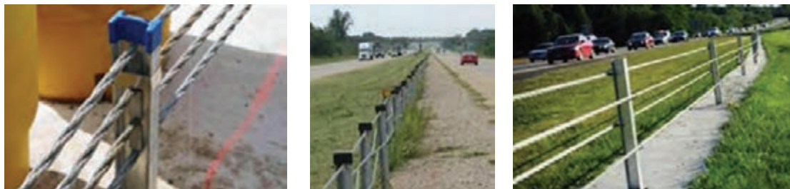
شکل ۴۶- نمونه‌هایی از اتصال کابل به پایه‌ها
