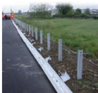
شکل ۴۳- نمونه‌ای از نصب پایه‌های گاردریل با ریسمان‌کشی
