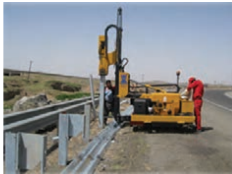
شکل ۴۴- پایه کوبی، نصب لقمه
