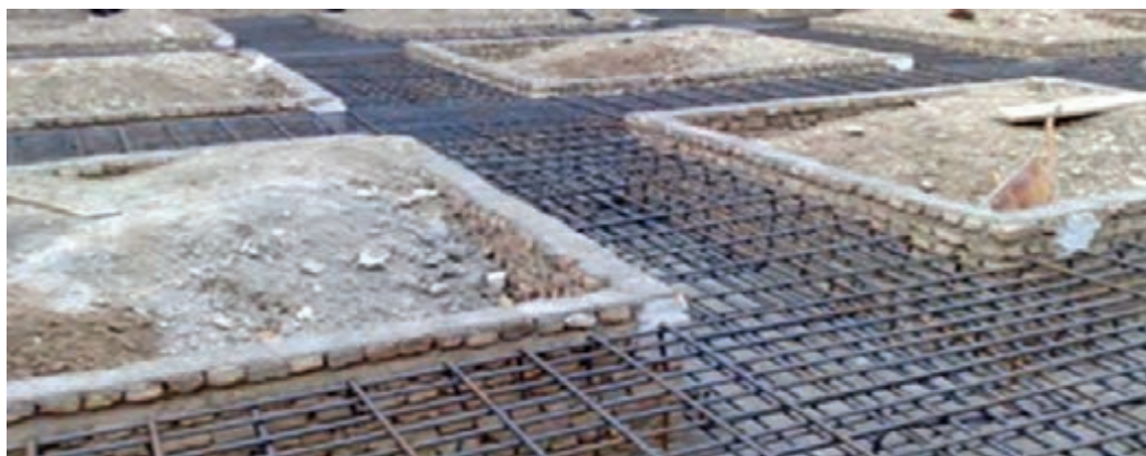
شکل ۱۴- ساخت (مونتاز) شبکه‌های آرماتور پی و آمادگی برای بتن‌ریزی و اجرای شالوده (فونداسیون) نواری بتنی مسلح، سازه‌ای اسکلتی را نشان می‌دهد.
