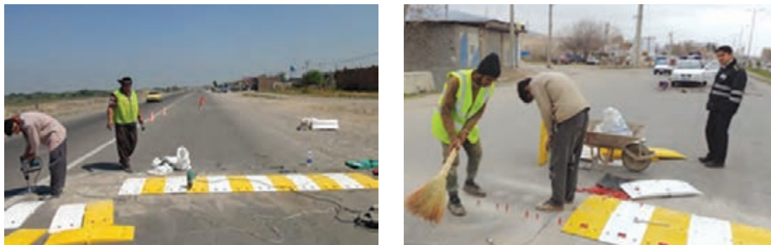
شکل ۱۵- نحوه نصب سرعت گیر پلاستیکی با استفاده از پیچ و مهره
