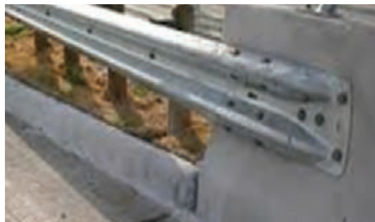
شکل ۸۱ - ناحیه انتقالی حفاظ دو موج به نیوجرسی
