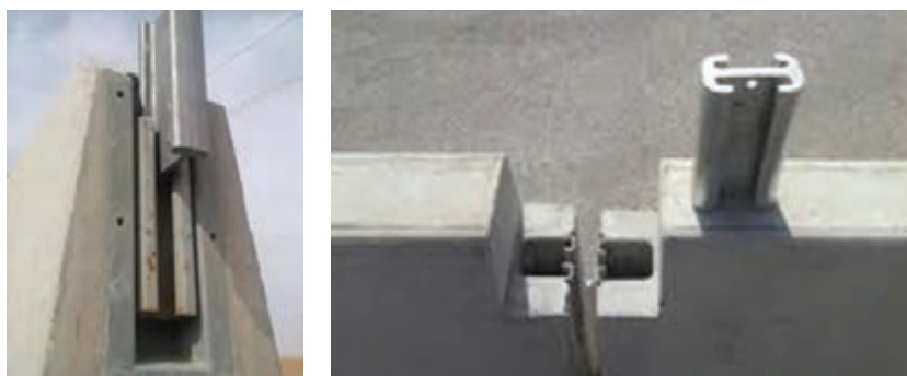
شکل ۵۴- نمونه قطعات بتنی جهت اتصال به روش مفصلی
