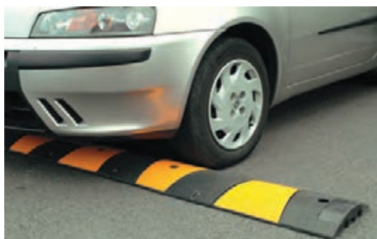
شکل ۵- نمونه‌ای از سرعت گیر
