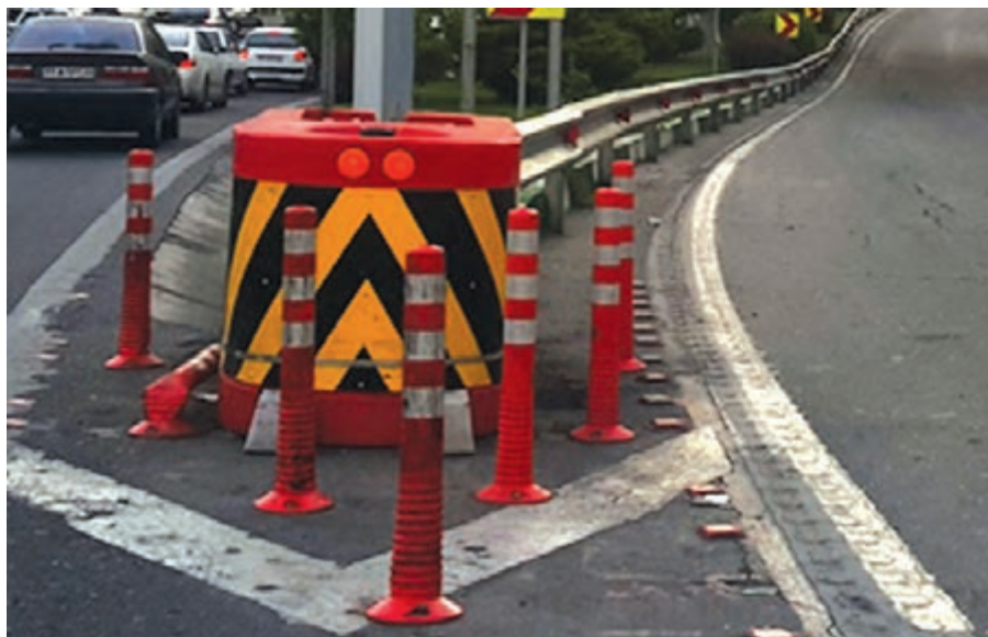
شکل ۲۱ - اجزای ضربه گیر ریلی در تهران
