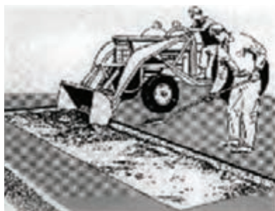
برداشتن لایه های آسفالتی و اساس
