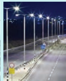
شکل ۷۶- ایمن سازی چراغ برق
