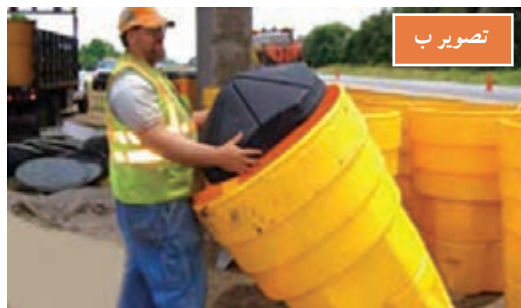
شکل ۲۲- چیدمان بشکه‌ها و قرار دهی مخروط درونی
