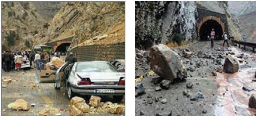
شکل ۵- تصاویری از ریزش سنگ در راه‌های کوهستانی
