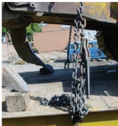
شکل ۲۷- بستن قسمت‌های مفصلی ماشین آلات راه‌سازی
