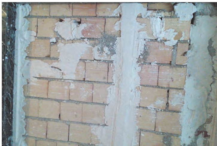
شکل ۲۴ ▲ شمشه‌گیری بین کرم‌ها
