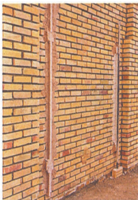
شکل ۲۳ ▲ شمشه‌گیری بین کرم‌ها
