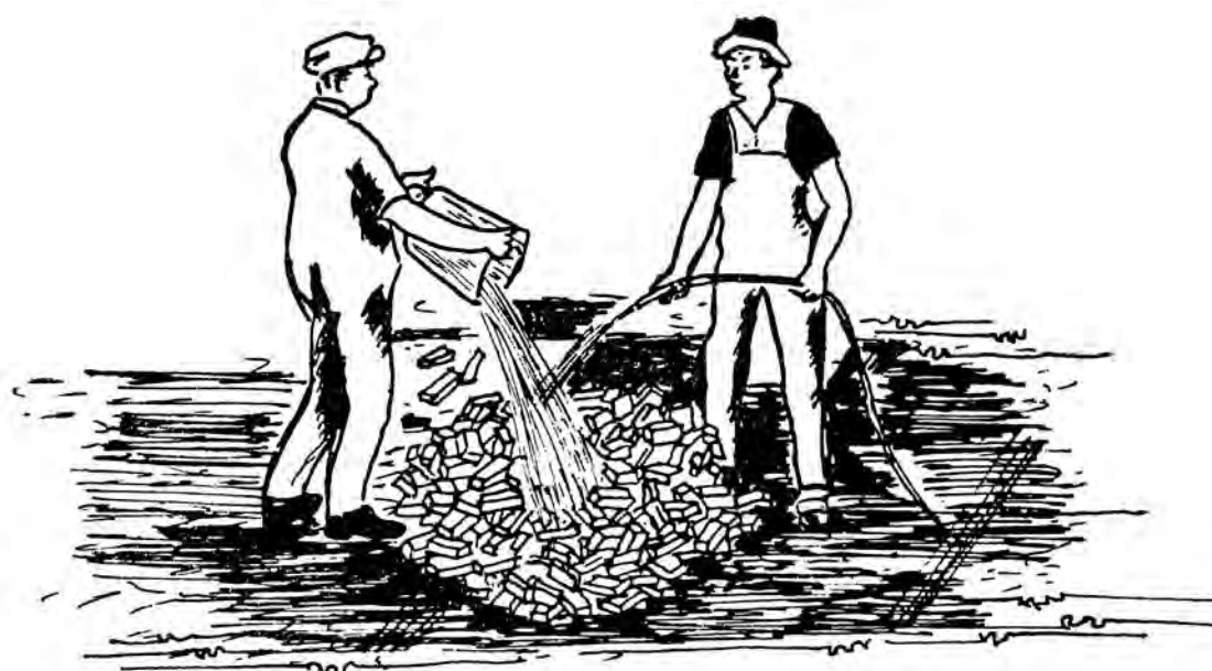
شکل ۳۷ ▲ زنجاب کردن آجر
