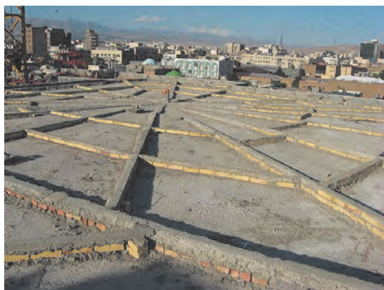
شکل ۱۴ ▲ کرم‌بندی و شمشه‌گیری بین آن‌ها
