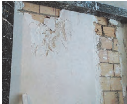
شکل ۲۵ ▲ پر کردن متن بین شمشه‌ها
