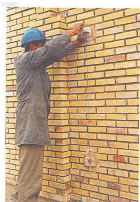
شکل ۲۰ ▲ شاقولی کردن کرم‌ها
