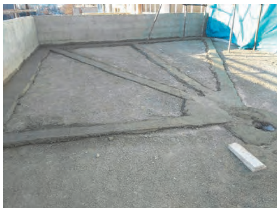
شکل ۱۴ ▲ کرم‌بندی و شمشه‌گیری بین آن‌ها
