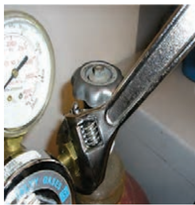
بازکردن شیر تنظیم از کپسول
