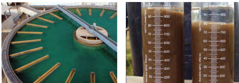
شکل ۴- نمایشی از فرایند ته‌نشینی و مخزن صنعتی آن
