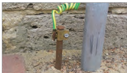
شکل ۴ - شیوه اتصال به چاه ارت
