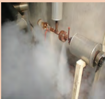
نشتی از اتصال در خط لوله
