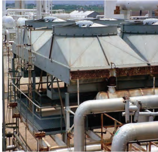
شکل ۳۳- انواع خنک‌کنندهٔ هوایی
