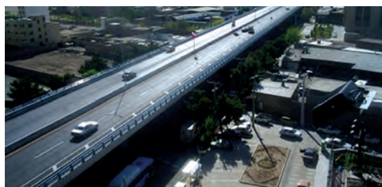
پل روگذر آزادراه از جنس فولاد آلیاژی
