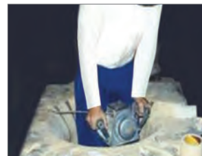
شکل ۱۳- کوبیدن نسوز کف کوره با کوبه ماشینی
