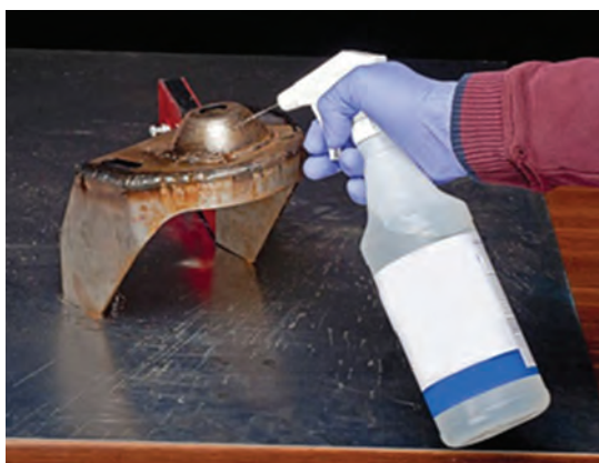
شکل ۴-۲۲- تمیزکاری بعد از جوشکاری توسط محلول شیمیایی
